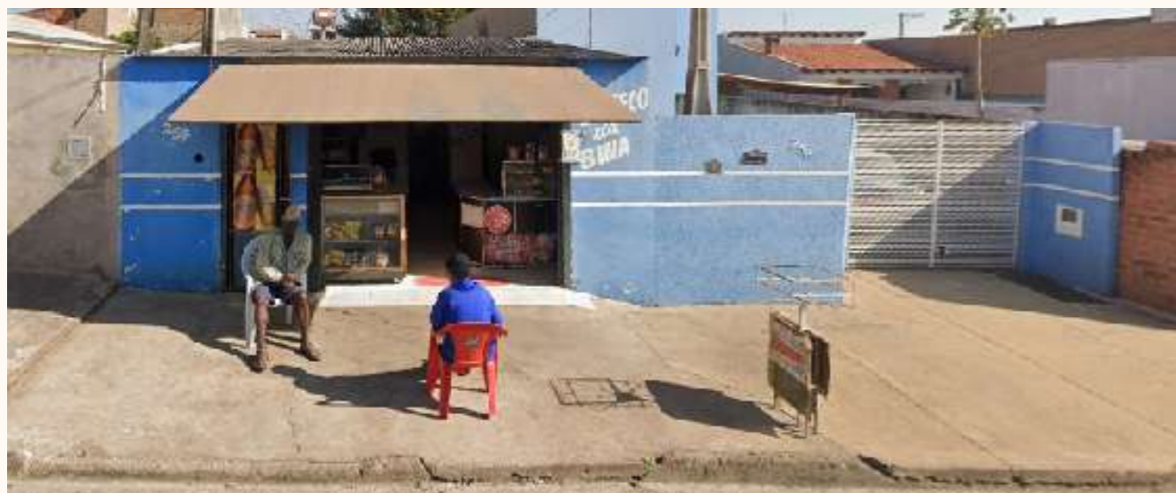
Bar do Bina. Fonte: Google Street View
