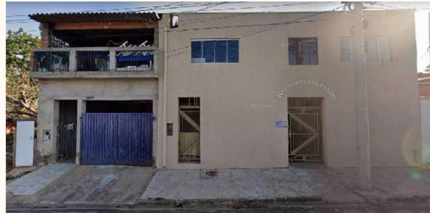
Igreja Jesus Está Voltando. Fonte: Google Street View
