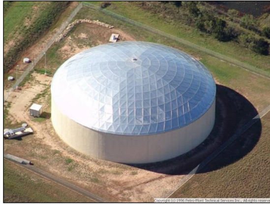
Figura 9 - Tanque envolto em domo
