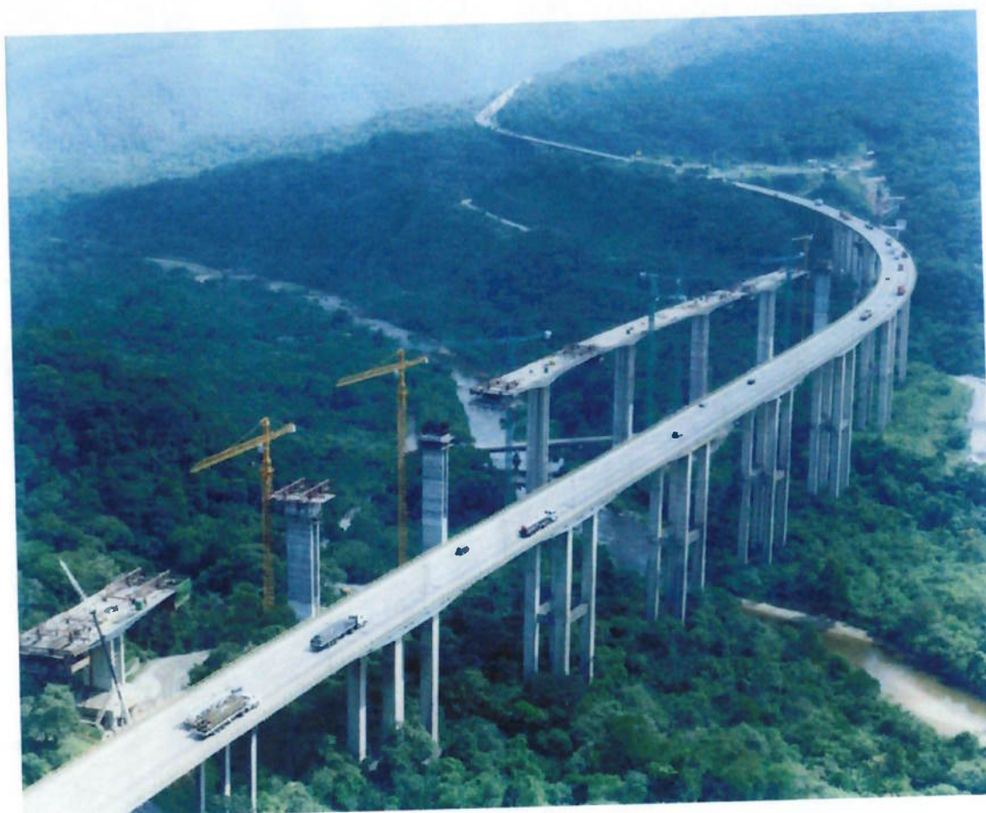
Figura 5: Viadutos com execução tipo balanço sucessivo. CONSÓRCIO IMIGRANTES, 2002
