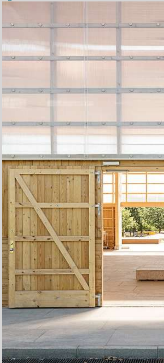
Figura: Fachada em Policarbonato translúcido
