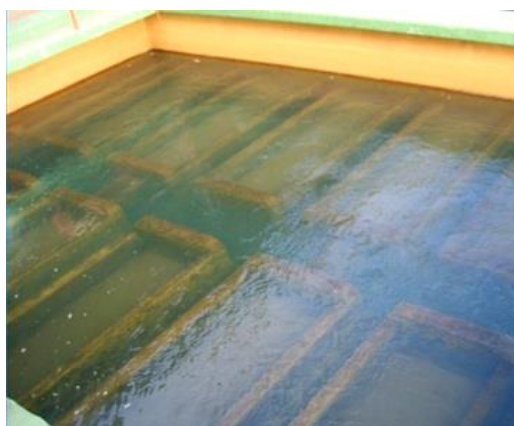
Figura 11 - Filtros de areia da ETA de São Carlos – SAAE
