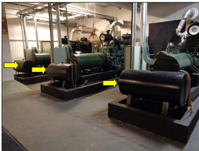
Figura 2 – Exemplo de tanque de consumo
