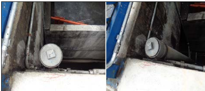
Figura 19 – Bocal de abastecimento
