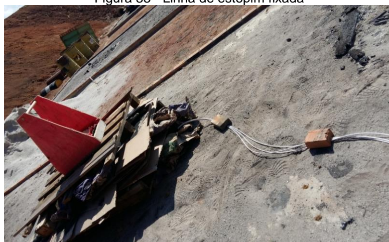
Figura 33 - Linha de estopim fixada
