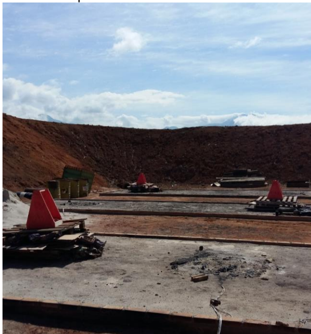
Figura 31 - Camas de queima montadas com a caixa de azida de chumbo
