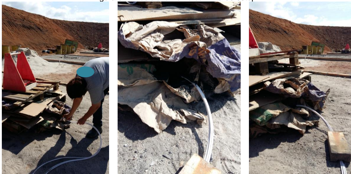
Figura 32 - Posicionamento da linha de estopim
