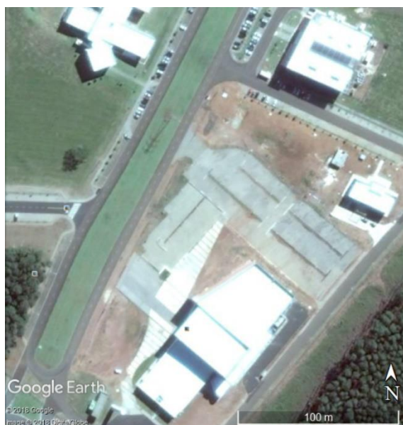
Figura 34: Local de instalação dos painéis. (Fonte: Google Earth)
