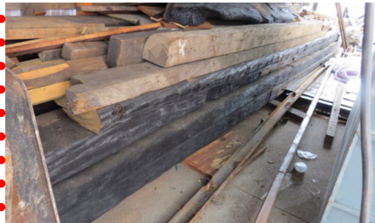
Armazenamento de madeira.
