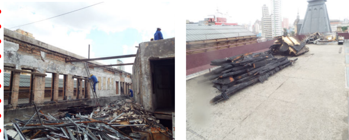
Seperação e armazenamento dos resíduos por tipo de material, prévios ao transporte para o t rreo.
