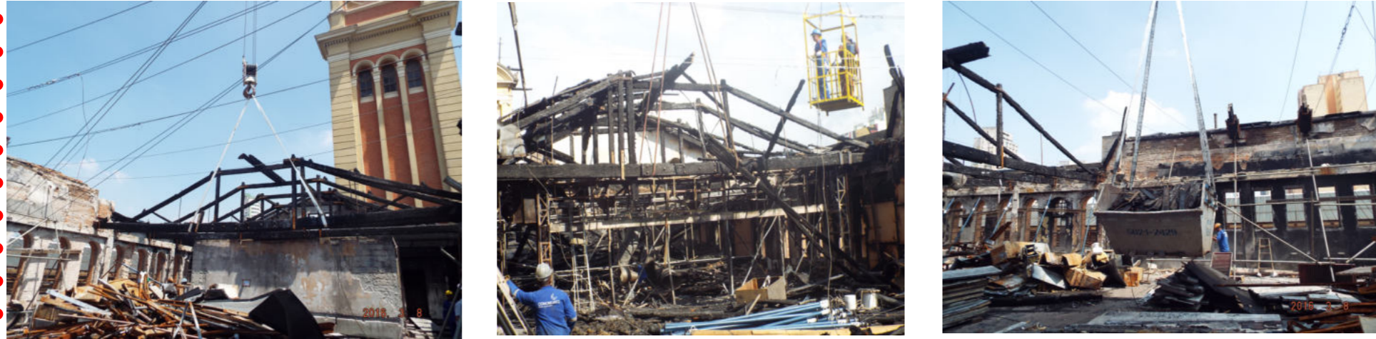
Içamento de treliças de madeira e caçambas pelo guindaste.
