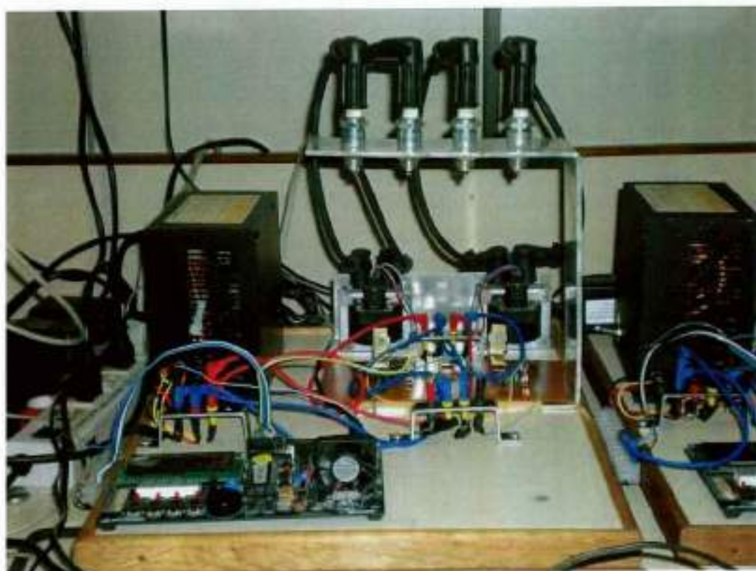
Figura 10. Visão geral do subsistema da ignição finalizado.
