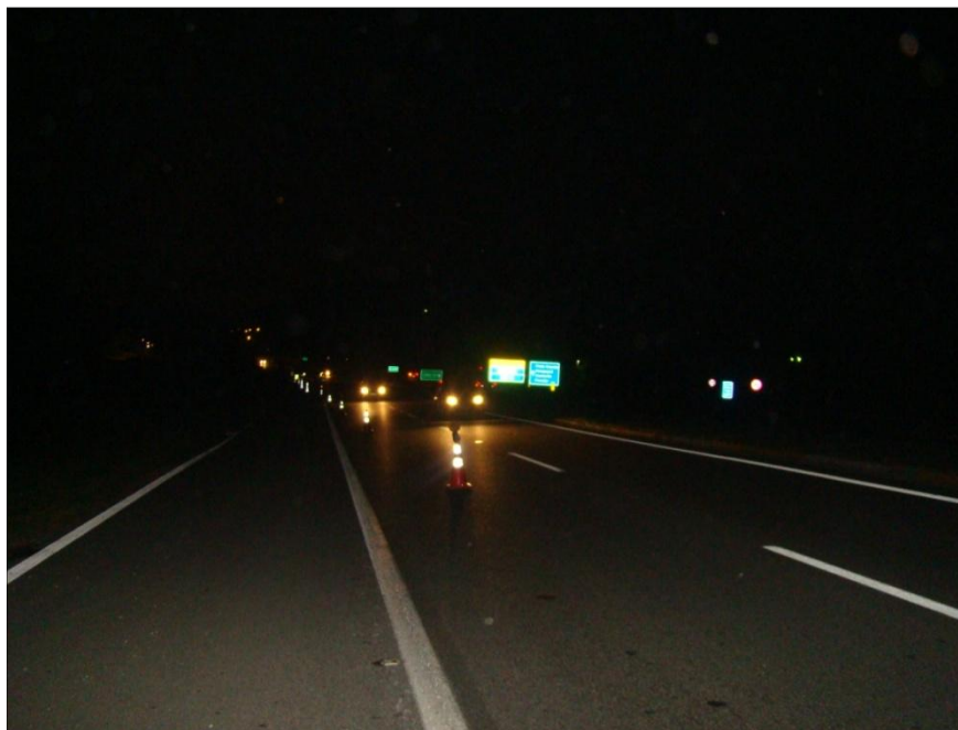
Figura 14 – Exemplo de sinalização conforme manual (formação agulha). Fonte: Acervo pessoal, 2014.
