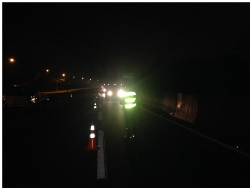
Figura 43 – Interrupção do tráfego durante a remoção do painel. Fonte: Acervo pessoal, 2014.
