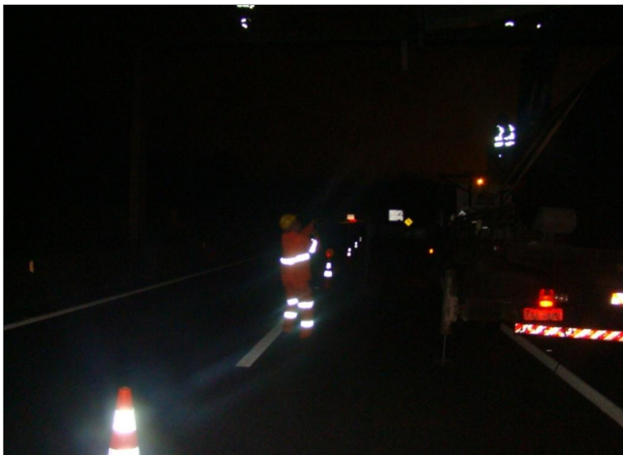
Figura 37 – Operário efetuando sua tarefa próximo a via com tráfego liberado. Fonte: Acervo pessoal, 2014.
