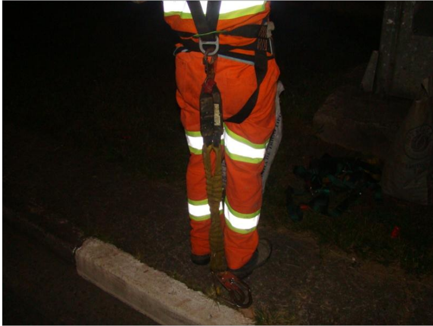
Figura 45 – Preparação do absorvedor de carga. Fonte: Acervo pessoal, 2014.
