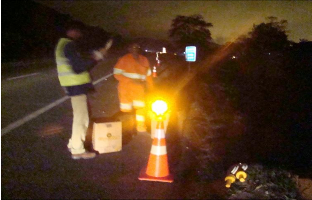
Figura 28 – Formação dos cones e instalação dos sinalizadores luminosos. Fonte: Acervo pessoal, 2014.
