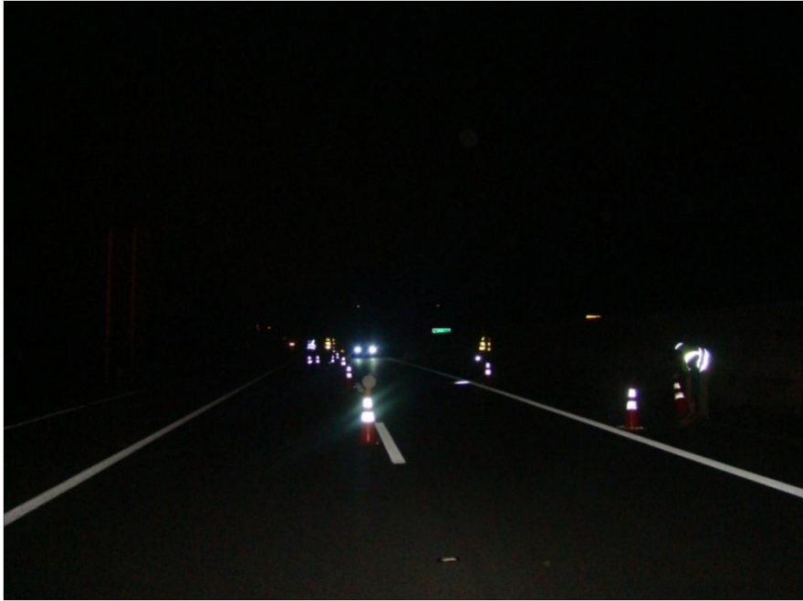
Figura 34 – Implantação de cones na faixa próxima a mureta. Fonte: Acervo pessoal, 2014.
