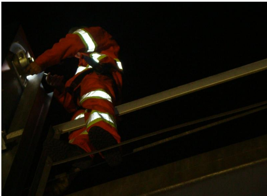
Figura 47 – Retirada dos parafusos de fixação do painel de suporte do pórtico. Fonte: Acervo pessoal, 2014.
