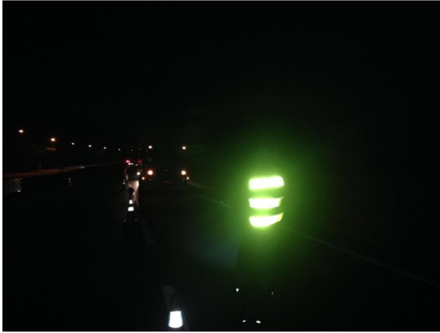
Figura 52 – Interdição do tráfego durante a retirada do painel. Fonte: Acervo pessoal, 2014.
