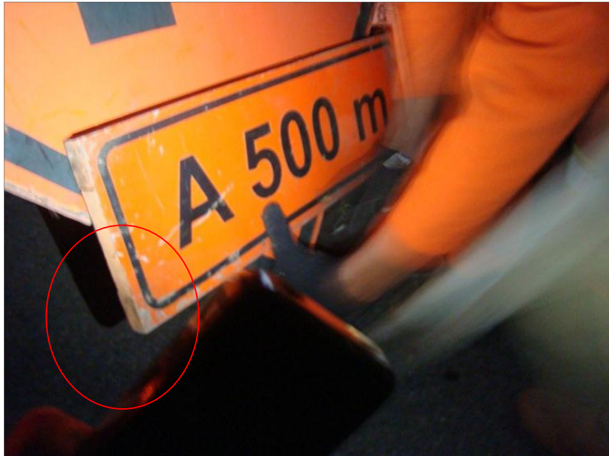
Figura 23 – Placa sem ponto de fixação. Fonte: Acervo pessoal, 2014.
