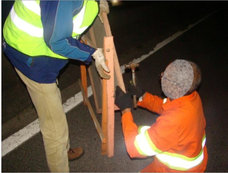
Figura 19 – Conserto do caveleto no acostamento. Fonte: Acervo pessoal, 2014.
