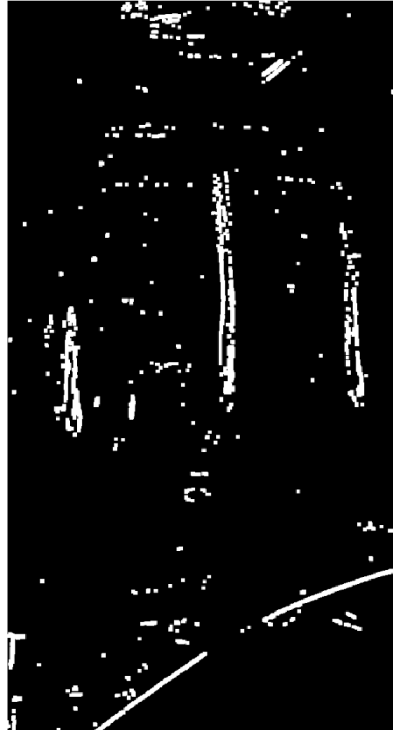
Figura 17: Imagem final após o processamento para detecção de trincas.
