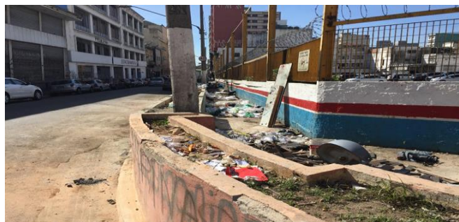
Figura 19: Resíduos sólidos depositados no passeio da intersecção da Rua dos Gusmões com a Avenida Rio Branco
