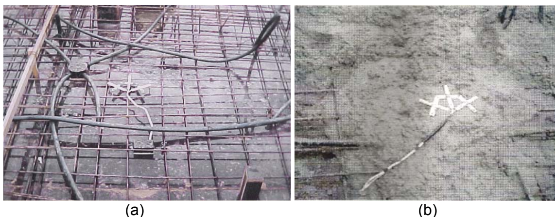
Figura 9.1 – Roseta instalada na partícula crítica (a) e posterior concretagem do dispositivo (b).
