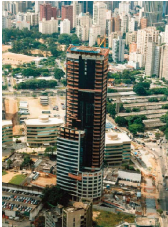
Figura 2.1.1 – Foto aérea do Edifício e-Tower que possui pilares com concretos de alto desempenho e resistências à compressão entre 109 a 149 MPa aos 28 dias. Fator água cimento = 0,19
