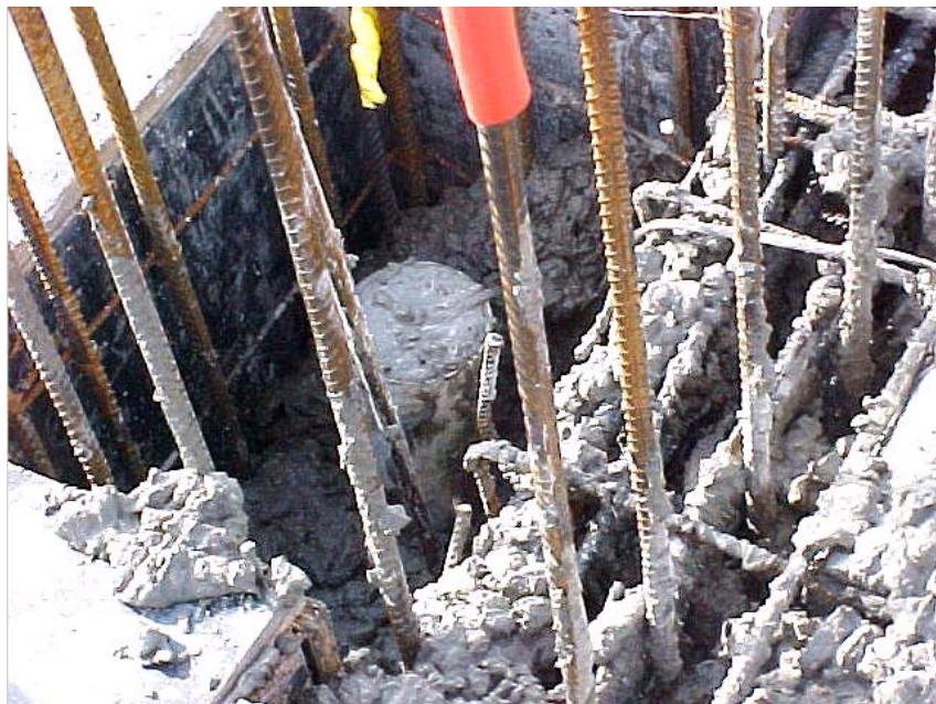
Figura 7.1.1 – Instalação e concretagem da célula de fluência e do compensador na estrutura da obra em local determinado pelo projetista estrutural
