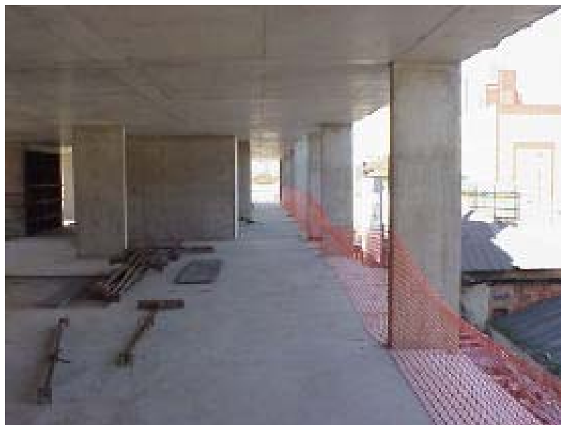
Figura 7.1.4 – Vista interna do pavimento da obra sem os escoramentos
