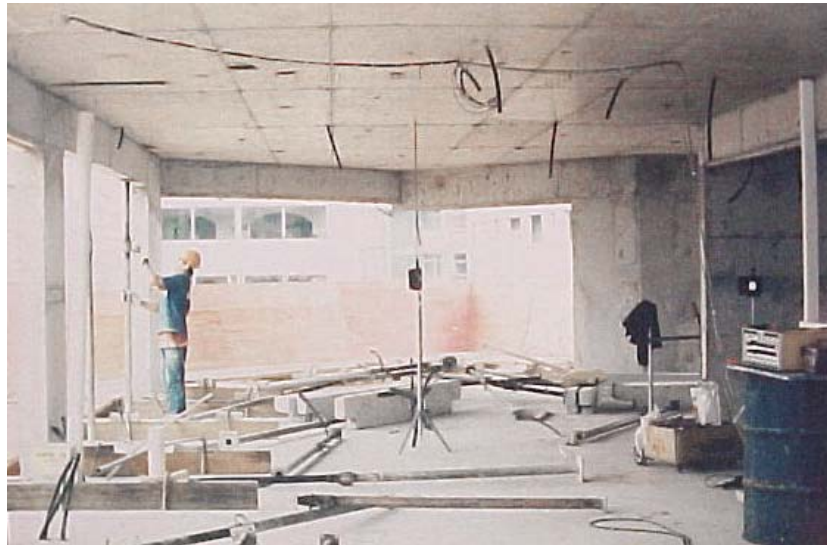
Figura 9.4 – Foto do deflectômetro mecânico instalado para leitura da flecha no ponto de maior deslocamento.
