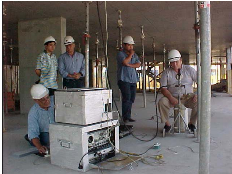
Figura 7.1.2 – Obtenção do módulo de elasticidade do concreto por meio da célula de fluência instalada na estrutura
