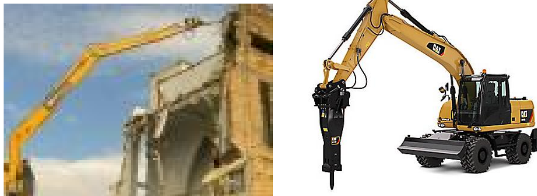
Figura 14: Rompedor hidráulico acoplado à uma escavadeira.
