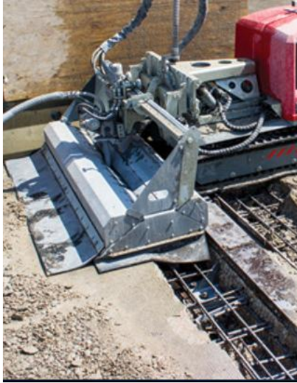
Figura 19: Equipamento de pressurização de água.
