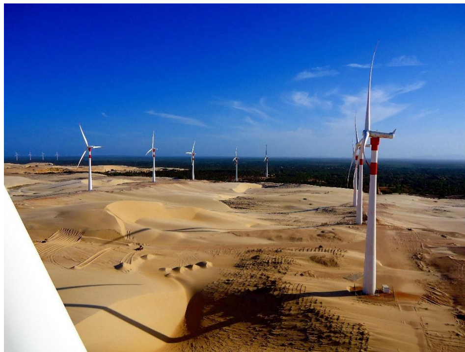
Figura 51: Parque Eólico Flexeiras I.
