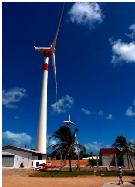
Figura 43: Aerogerador mais ao sul do Parque, o mais próximo das instalações construídas (almoxarifado e facilities ).
