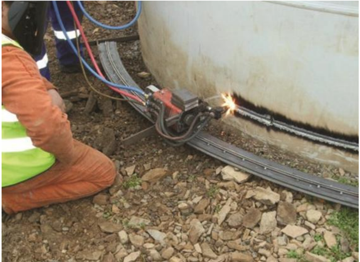
Figura 13: Utilização de um maçarico para torres de aço.
