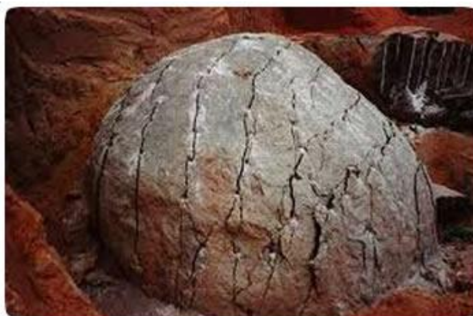
Figura 18: Rocha quebrada utilizando a argamassa expansiva.
