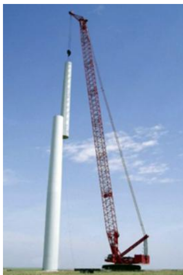
Figura 10: Montagem de uma torre de aço.
