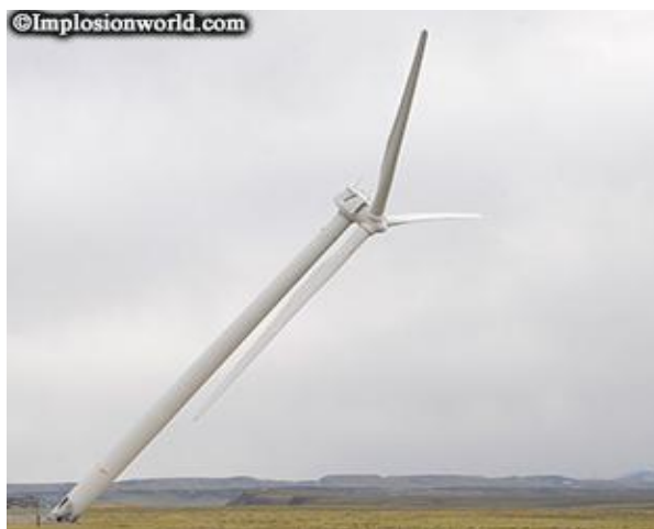
Figura 9: Implosão de uma turbina eólica.
