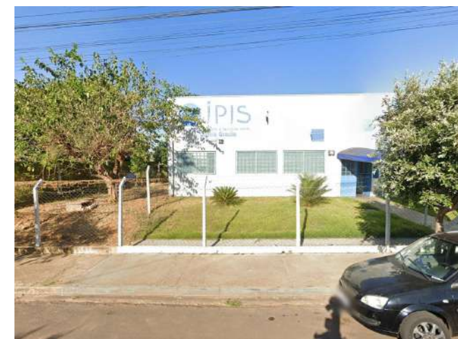
Fachada do Instituto. Fonte: da autora.
