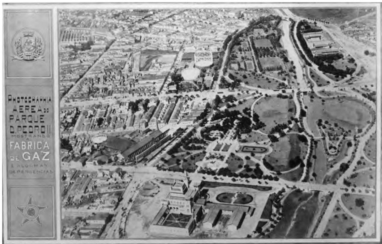
Figura 6 - Fotografia aérea do Parque Dom Pedro II em 1929. Reproduzido de Ribeiro (2012). Original: Acervo Fundação Energia e Saneamento.
