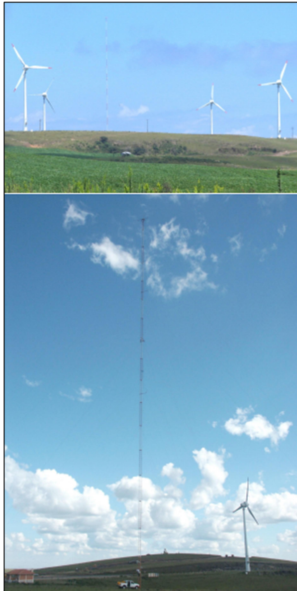
Figura 24 - Montagem de torre de 100 metros de altura, Palmas/PR (Manual COPEL, 2007)
