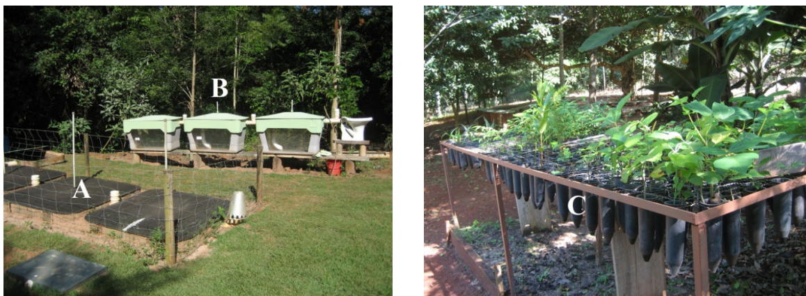
Figura 3 - A – Fossa séptica biodigestora; B – Protótipo didático da fossa para as atividades de educação ambiental; C – Tubetes com mudas para reflorestamento onde é aplicado o efluente da fossa séptica biodigestora
