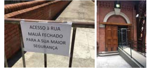
Figuras 35 e 36: Acessos da Estação da Luz à Rua Mauá bloqueados em Novembro de 2023.
