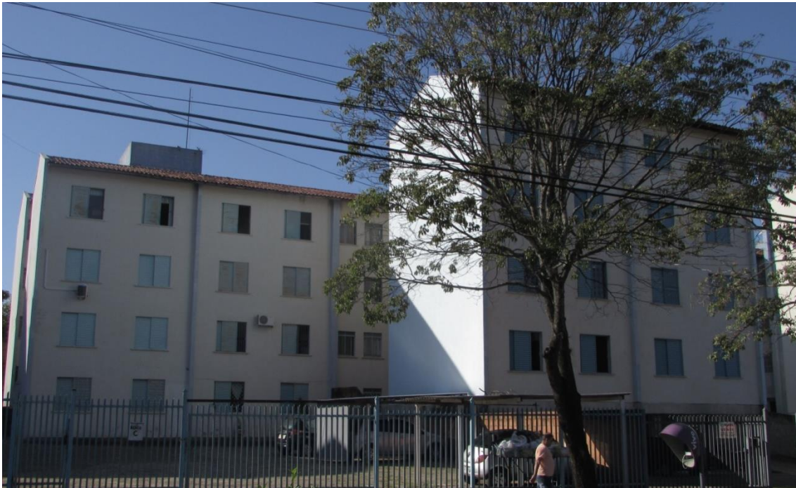
Figura 49 - Condomínio de Baixo Padrão Consolidado.
