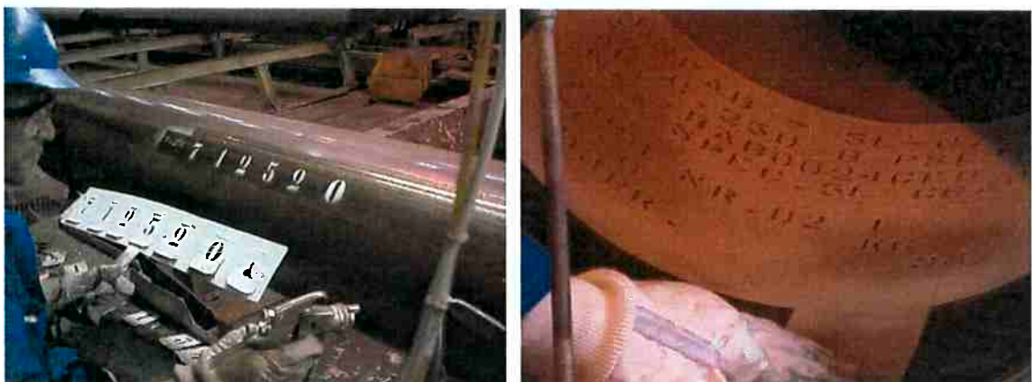
Figura 12 – Etapa de identificação dos tramos [16].
