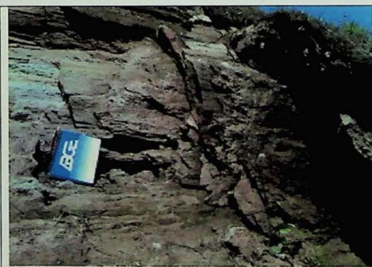
Figura 6.1.1.1: Foto de campo, vista de corte de talude com gnaisse milonítico de foliação subvertical causando deslocamento.
