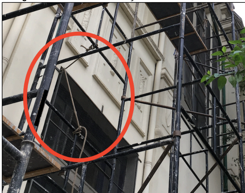
Figura 27 – Detalhe de amarração do andaime na fachada
