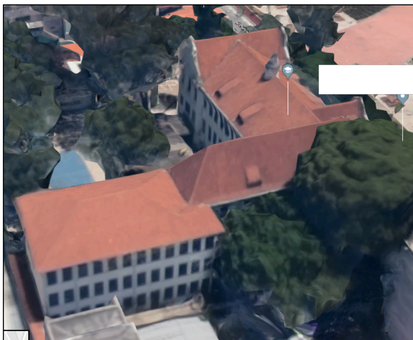
Figura 22 - Imagem aérea – edifício principal
