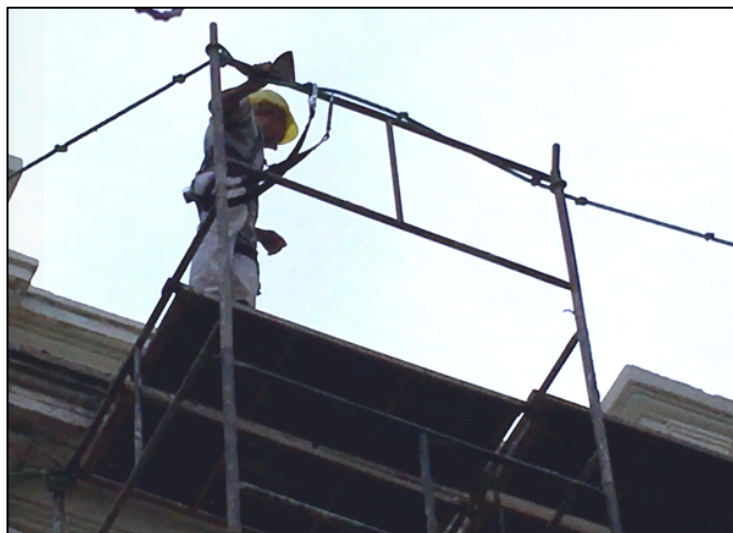
Figura 32 – Trabalhador conectado ao andaime
