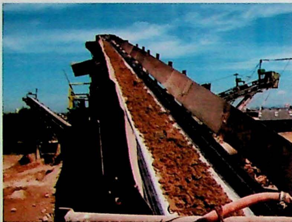
Transportador de correia do material britado
