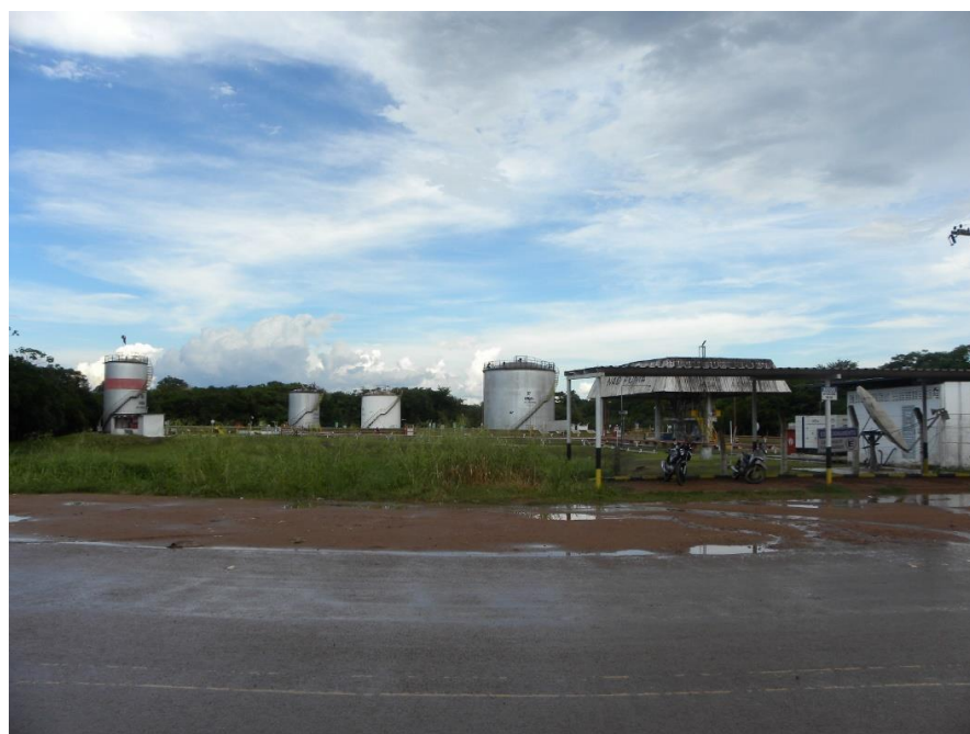
Foto 4 - Vista de TRRNI
