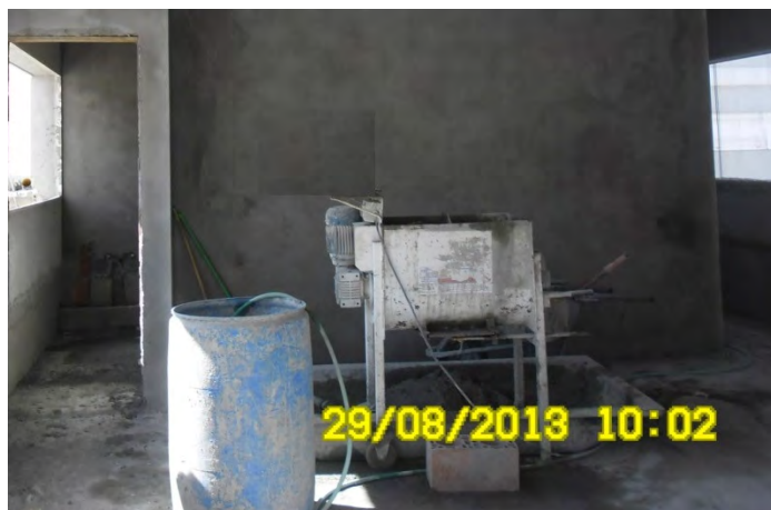
Figura 41 - Misturador de eixo horizontal
