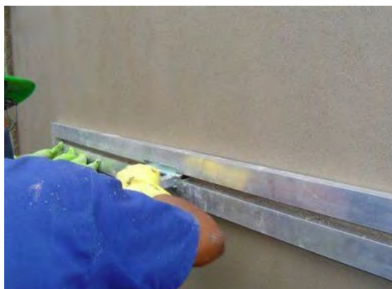
Figura 35 - Régua para frisar argamassa – Fonte: www.equipaobra.com.br
