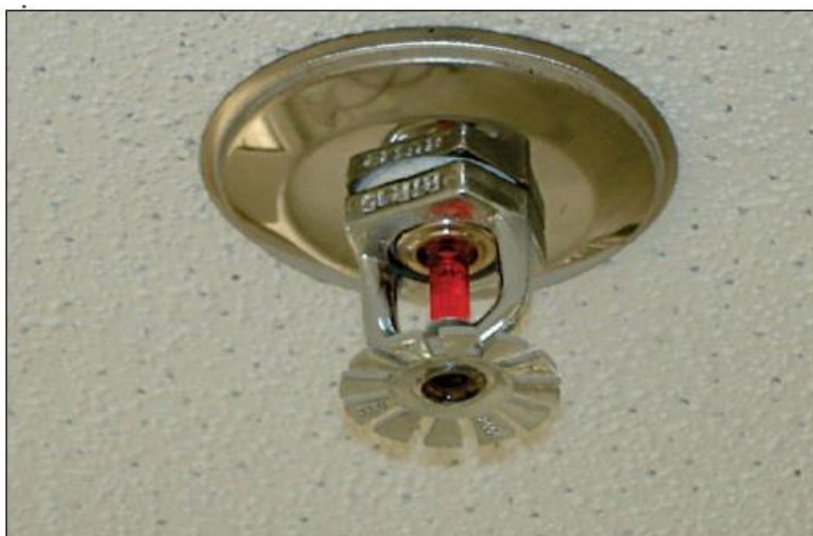
Figura 15 – Exemplo genérico de chuveiro automático com ampola de vidro
