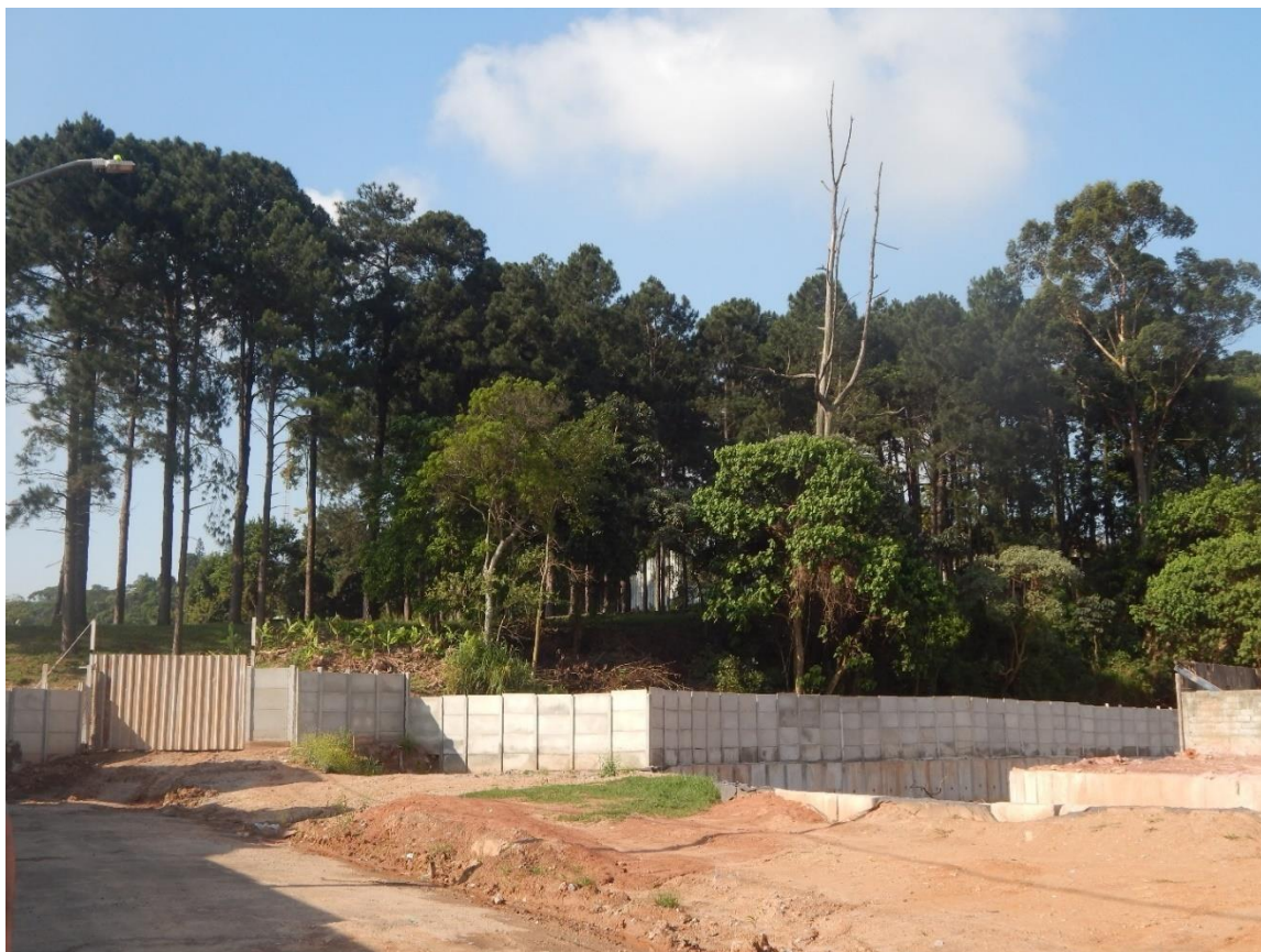
Figura 7.4 – Rua Ângelo Sampaio, altura do número 30 ao final de outubro de 2024. Obras de canalização já avançadas. Fonte: Autor
