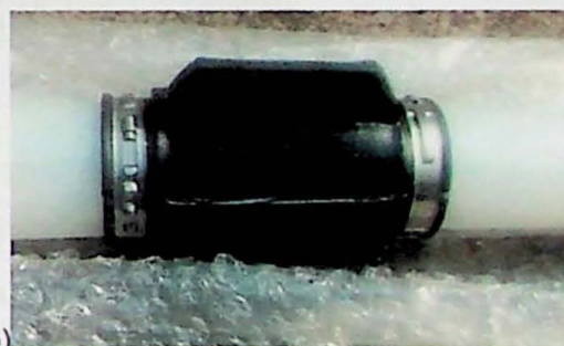
Figura 10 – a) Tela de aço inoxidável instalada, b) Centralizador instalado.
