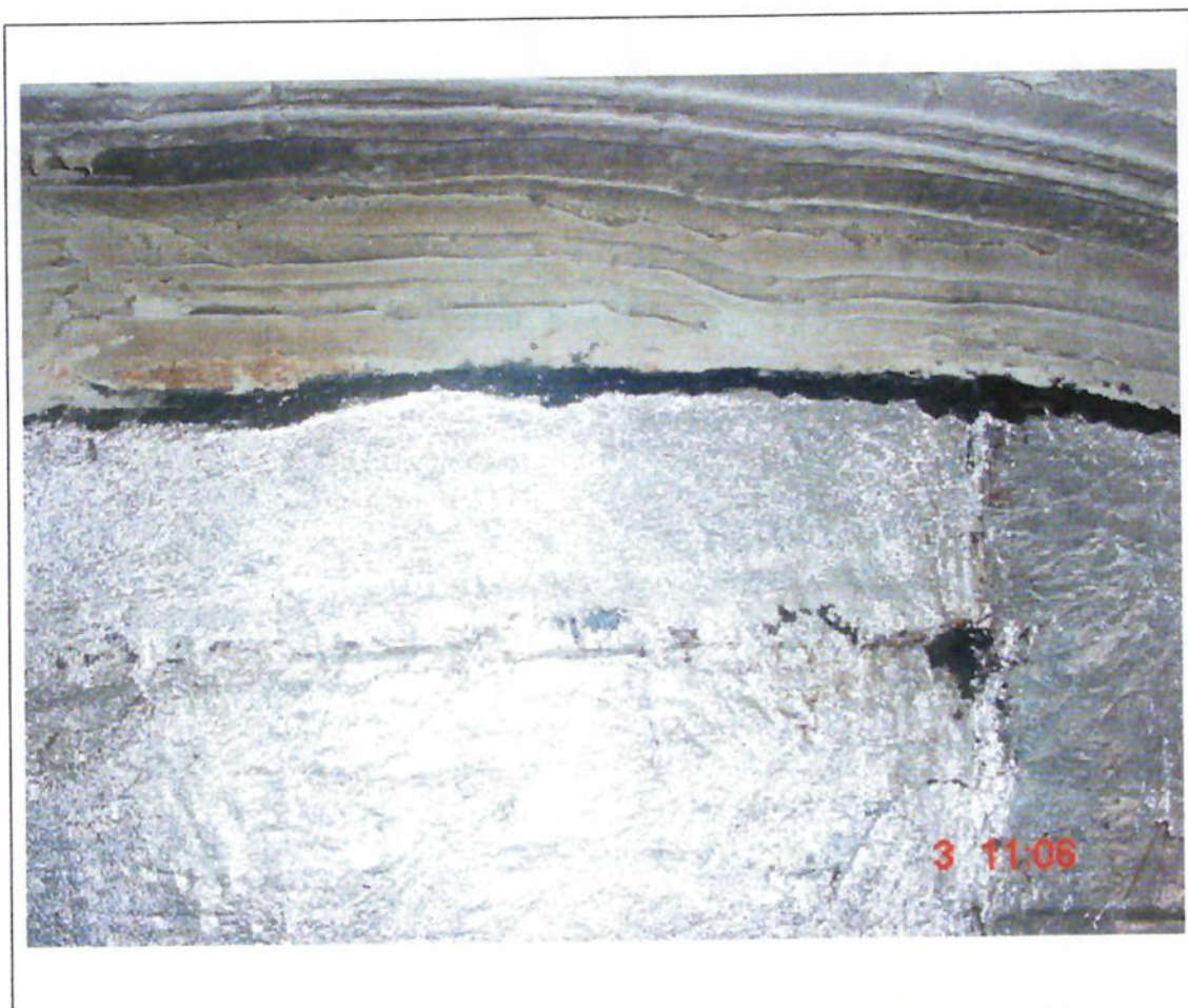
Figura 3.8: Revestimento Moter plas Alumínio
