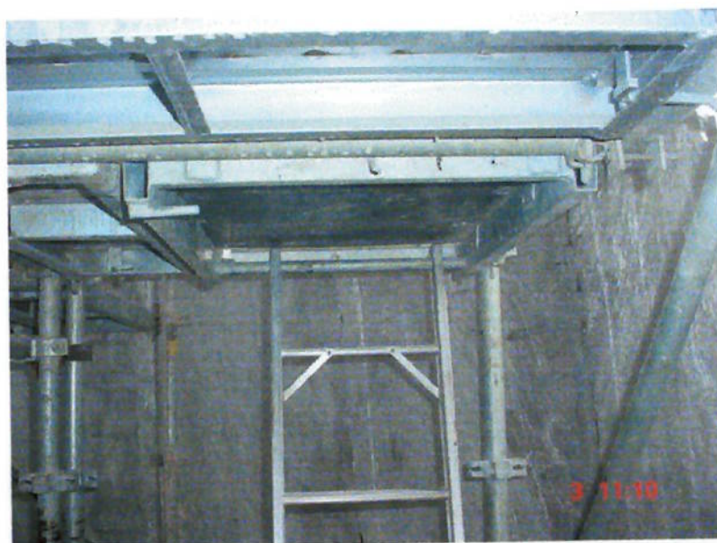
Figura 3.7: Plataforma do andaime interno
