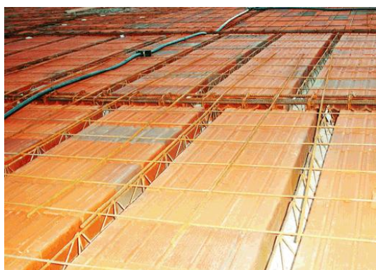
Figura 16 – Laje com bloco cerâmico [11]
