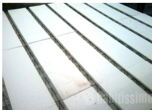
Figura 17 – Laje com bloco em EPS [12]
