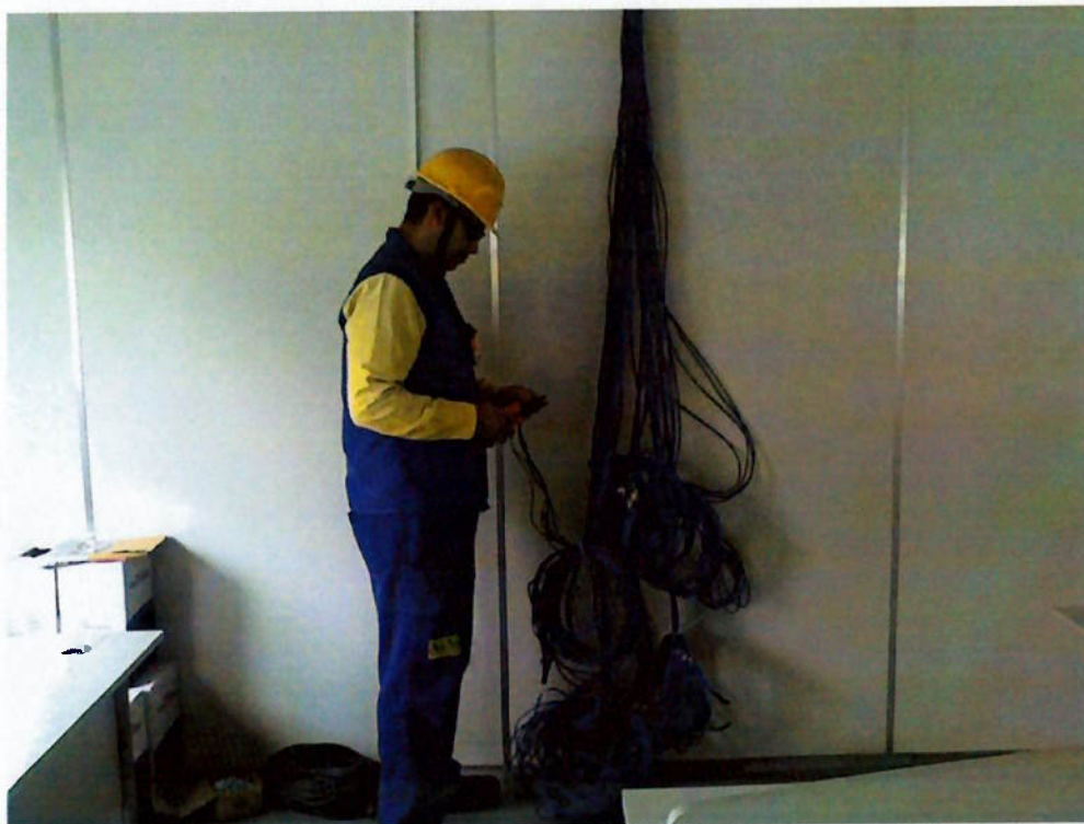
Fotos 17 Lançamento de cabos. (cortesia A&M eng. Associados Ltda)
