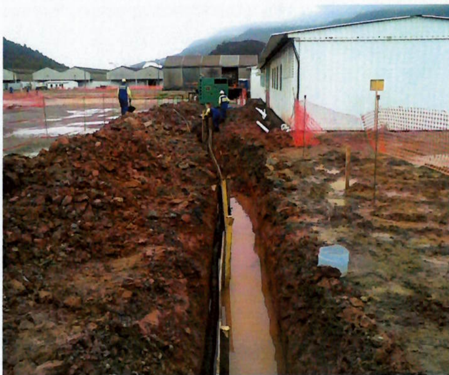
Fotos 34 Preparo da infra-estrutura de lançamento dos cabos alimentadores.
