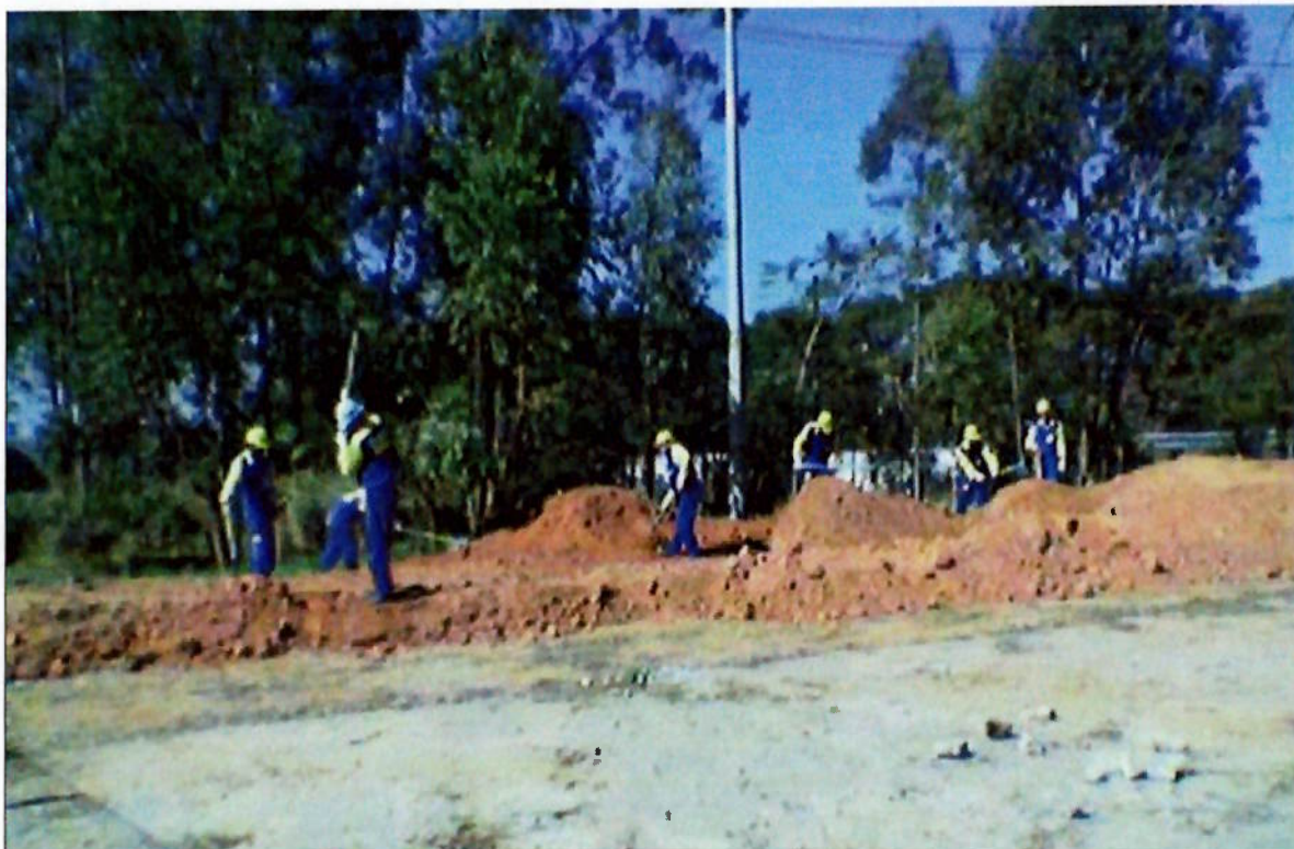
Foto 12. Preparo final do terreno para implantação dos módulos metálicos
