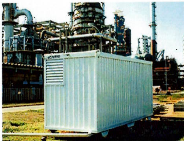
Foto 8. Módulos pré-fabricados habitacionais tipo contêineres individuais. (cortesia Eurobrás)
