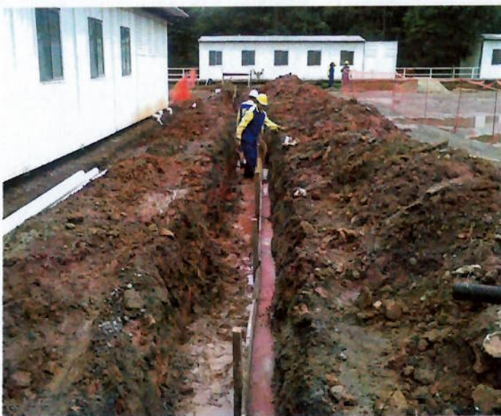
Foto 35. Envolvimento. (cortesia A&M eng. Associados Ltda)
