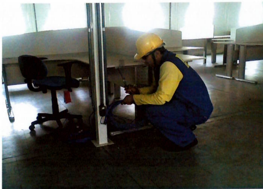
Foto 18. Montagem de tomadas da rede lógica e telefonia. (cortesia A&M eng. Associados Ltda)
