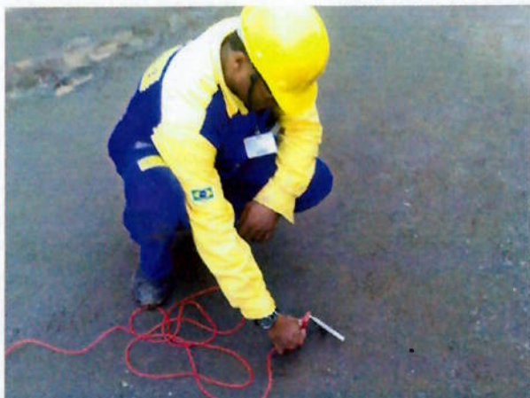
foto 44. verificação da resistência do aterramento. (cortesia A&M eng. Associados Ltda)
