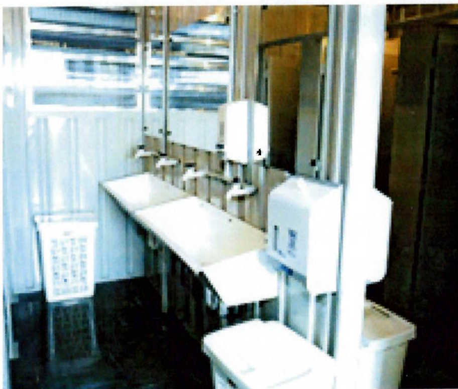
Foto 3. Sistemas de canteiros empregados atualmente (Cortesia Eurobrás)
