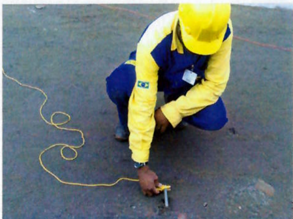
Foto 45. Inserção de hastes no solo. (cortesia A&M eng. Associados Ltda)
