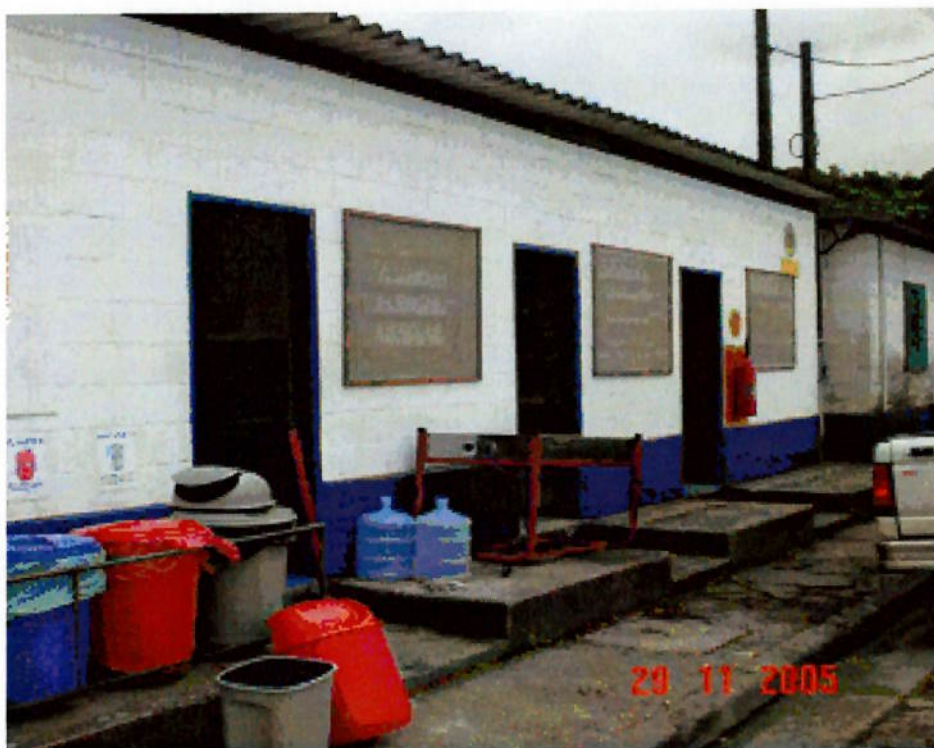
Foto 6. Exemplo de canteiro em alvenaria (cortesia A&M Eng. Associados Ltda)
