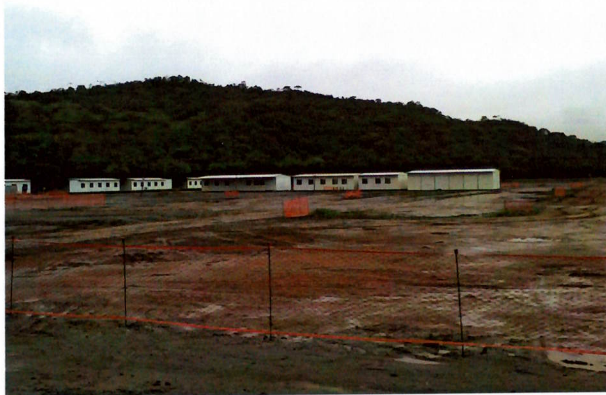
Foto 15. Vista geral dos módulos metálicos já montados. (cortesia A&M eng associados Ltda)
