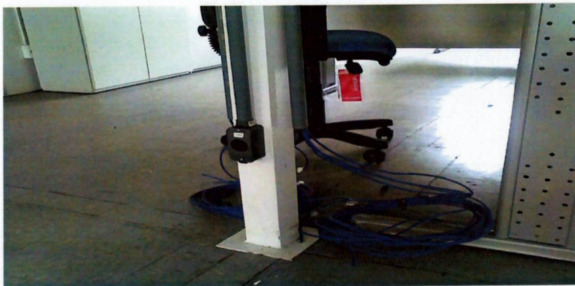
Foto 21. Detalhe da montagem da tomada de energia 2P+T. (cortesia A&M eng. Associados Ltda)
