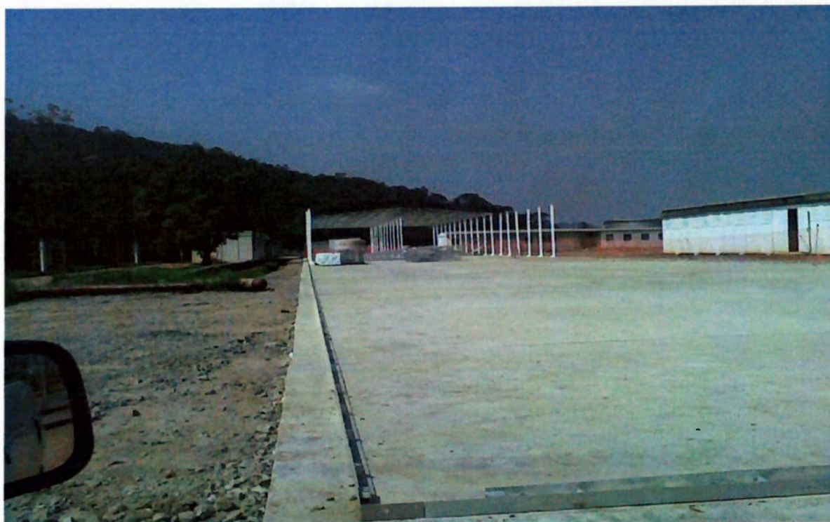
Foto 13. Contrapiso executado e montagem dos módulos metálicos.
