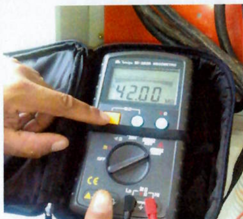
Foto 42. Verificação da continuidade dos circuitos e falha no isolamento.
