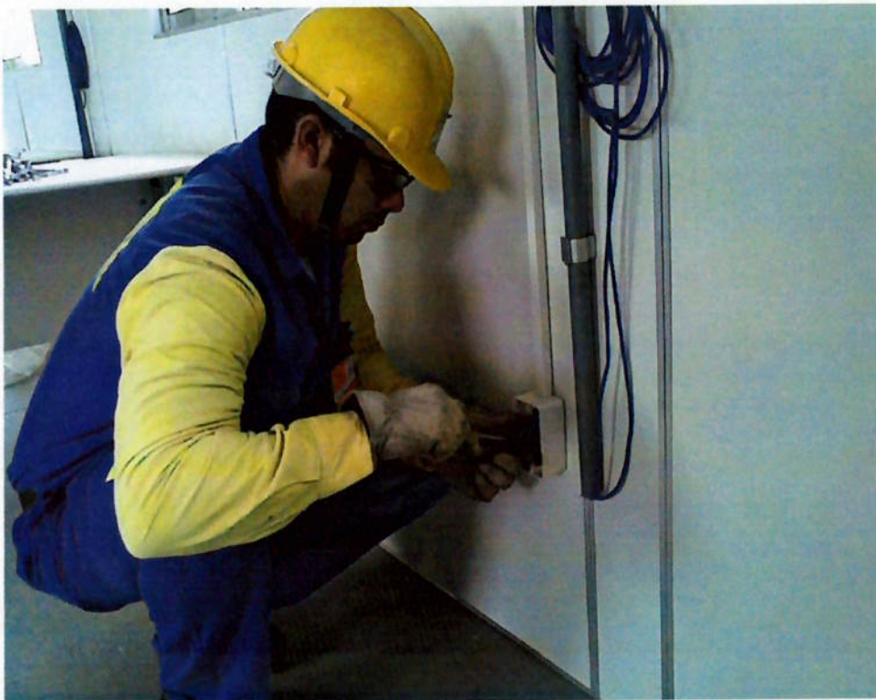
Foto 19. Montagem de tomada de energia. (cortesia A&M eng. Associados Ltda)
