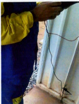
Foto 41. Verificação da continuidade dos circuitos e falha no isolamento.
