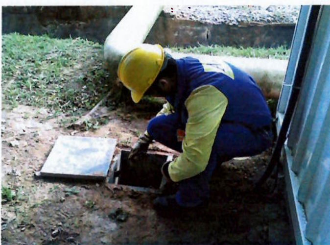
Foto 38. Lançamento de cabo alimentador. (cortesia A&M eng. Associados Ltda)
