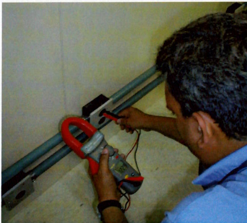
Foto 49. Verificação da tensão no circuito de tomadas.
