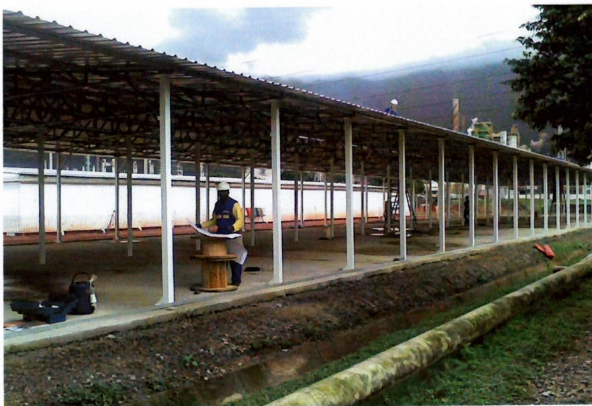
Foto 14. Preparo da infra-estrutura elétrica antes do fechamento das paredes e forros.
