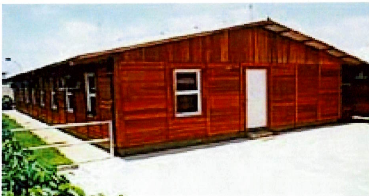
Foto 5. Exemplo de canteiro em sistema pré-fabricado em chapa de madeira (cortesia Eurobrás)
