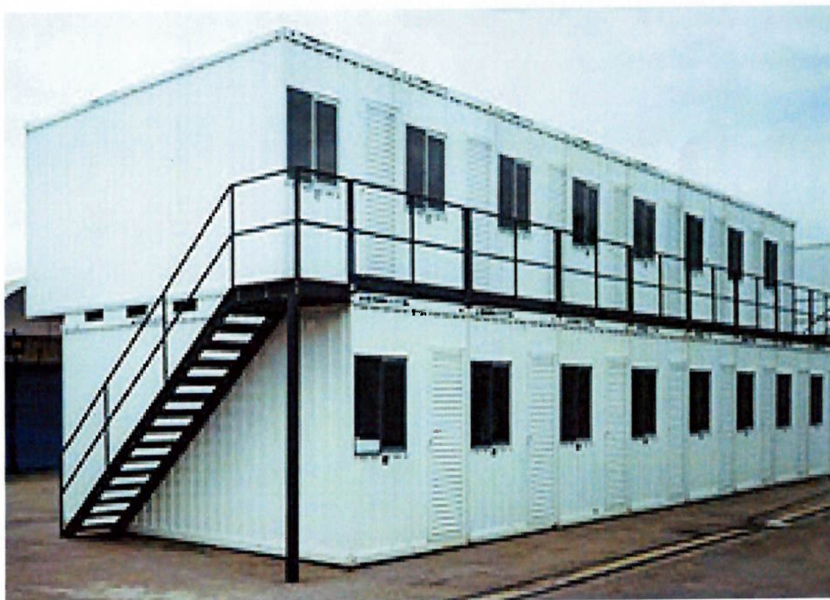
Foto 7. Exemplo de canteiro em construção metálica.
