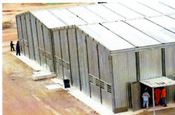
Foto 11. Galpões metálicos (cortesia Eurobrás)
