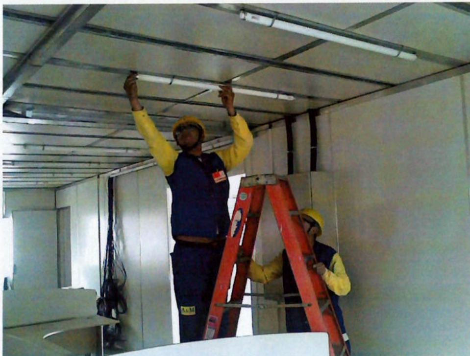
Fotos 32. Montagem das lâmpadas em áreas de escritório. (cortesia A&M eng. Associados Ltda)
