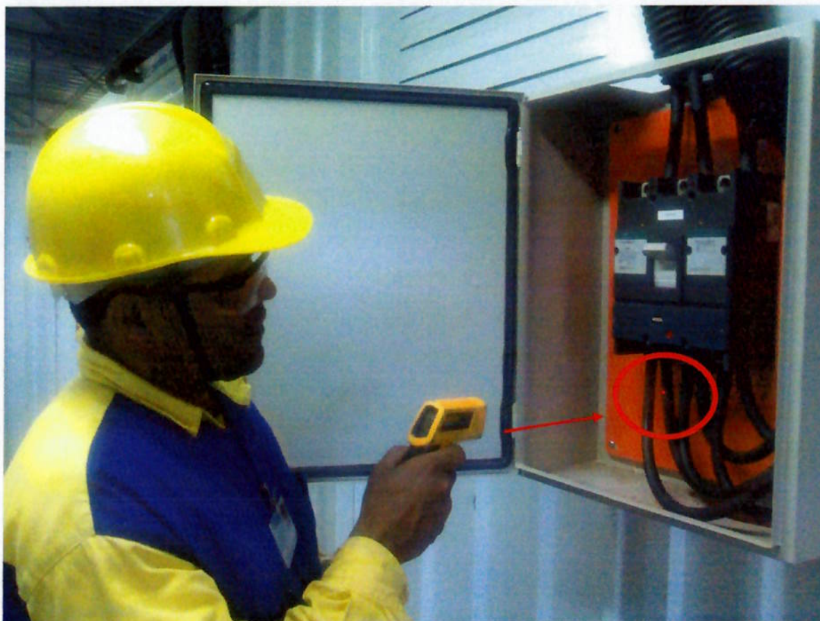
Foto 47. Verificação da temperatura de utilização. (cortesia A&M eng. Associados Ltda)
