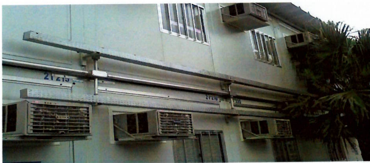
Foto 16. Montagem da infra-estrutura externa e instalação do sistema de conforto térmico.
