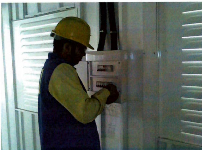
Foto 29. Instalação da barreira contra contato direto. (cortesia A&M eng. Associados Ltda)
