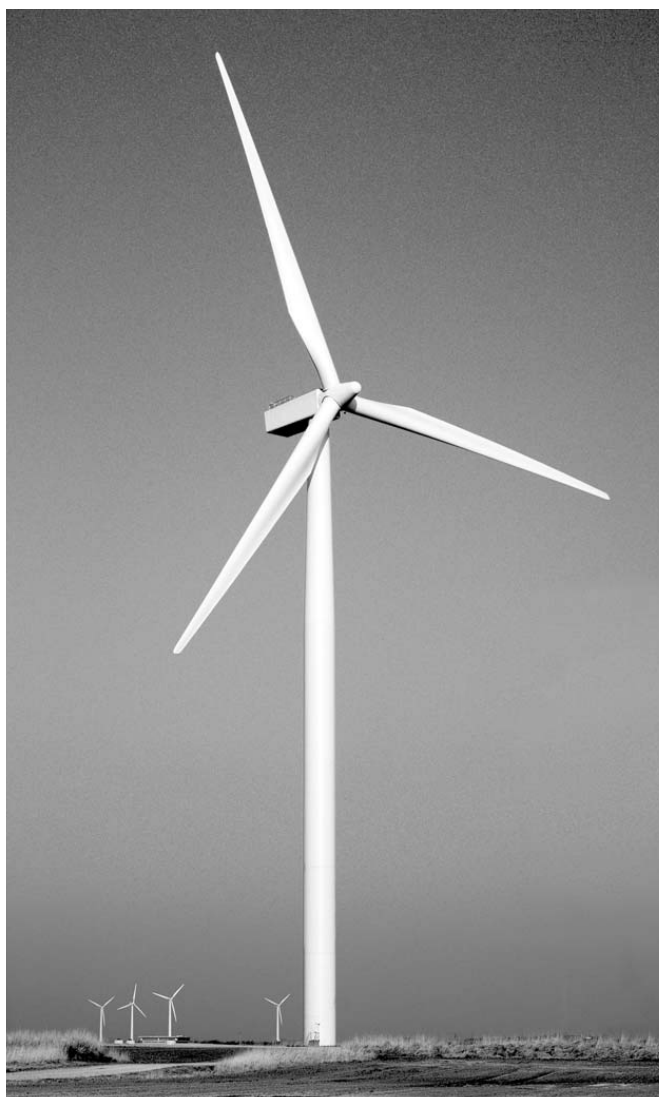
Figura 2.5 – Aerogerador Siemens de 107 metros de diâmetro de rotor
