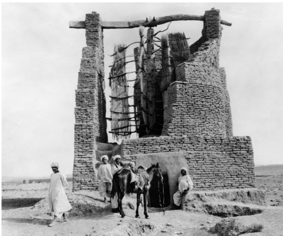
Figura 2.1 – Moinho de grãos de eixo vertical encontrado no Afeganistão
