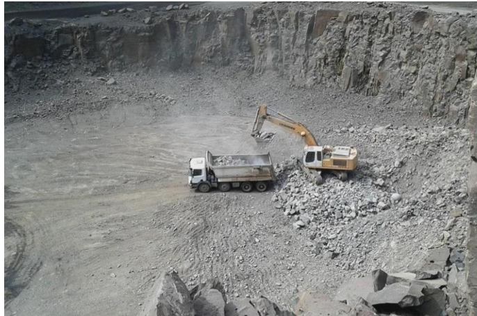
Figura 10 - Carregamento do caminhão com escavadeira
