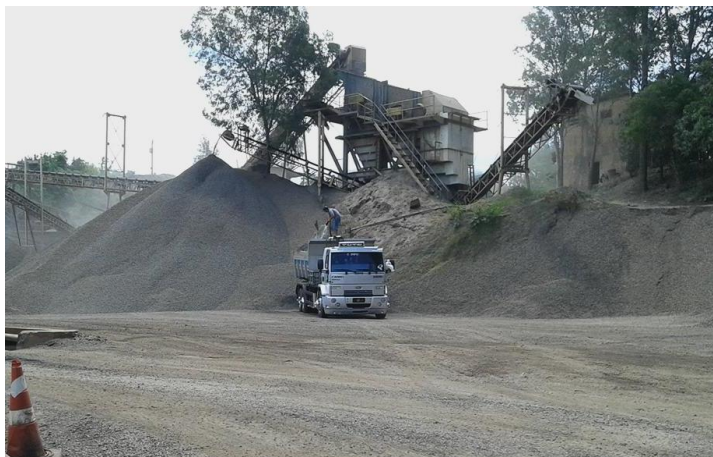
Figura 13 - Produto final da pedra britada e caminhão para carregamento.
