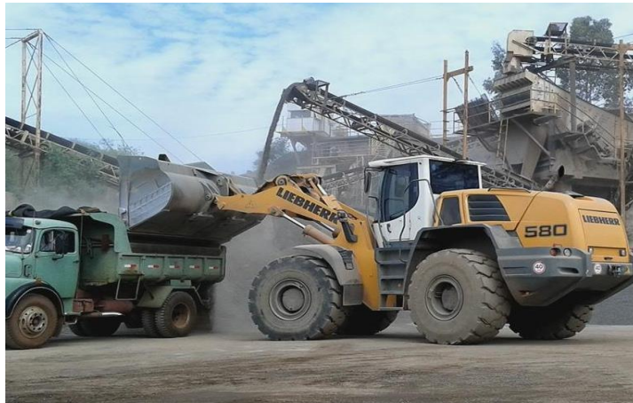
Figura 15 - Carregamento de caminhão carreta com pá carregadeira.
