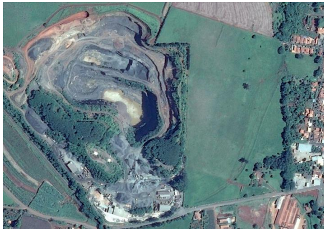
Figura 07 - Figura Aérea da Mineradora em Estudo.
