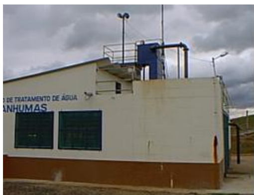
Vista geral da ETA
