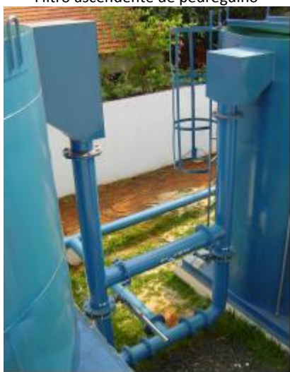
Interligação entre os filtros ascendente e descendente
