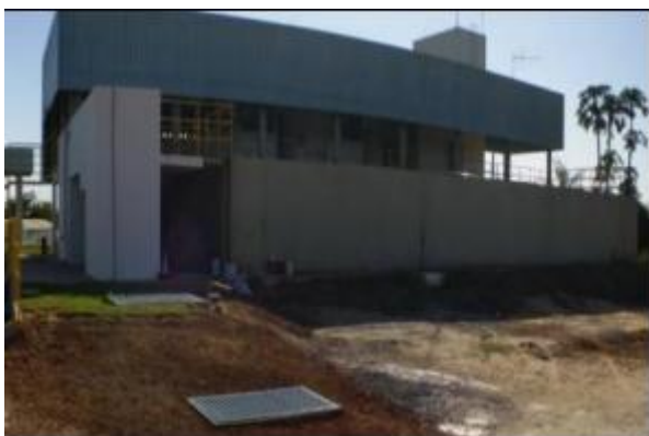
Vista Geral da ETA
