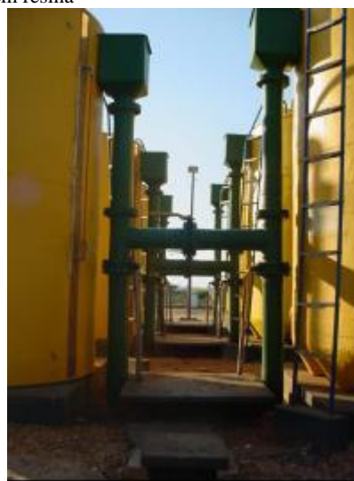
Interligação entre o filtro ascendente e o descendente
