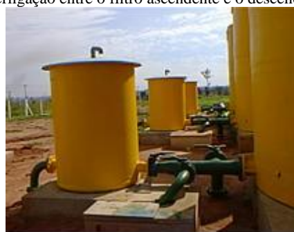
Interligação entre o filtro ascendente e o descendente
