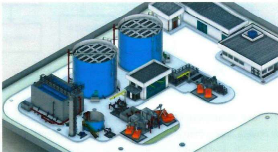
Figura 4.4.8 – Estação de Tratamento Esgoto de 38 e 60 L/s Fonte – (Vitalux Ecoativa)
