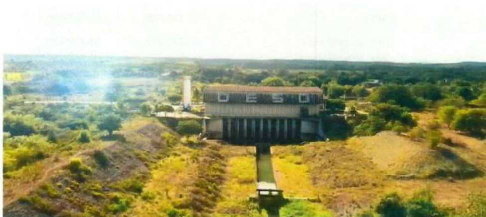
Figura 4.5.11 – Estação Elevatória de Água Bruta do Rio São Francisco Fonte – (Vitalux Ecoativa)
