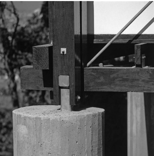
Detalhe encaixe fundação - estrutura, Nelson Kon
