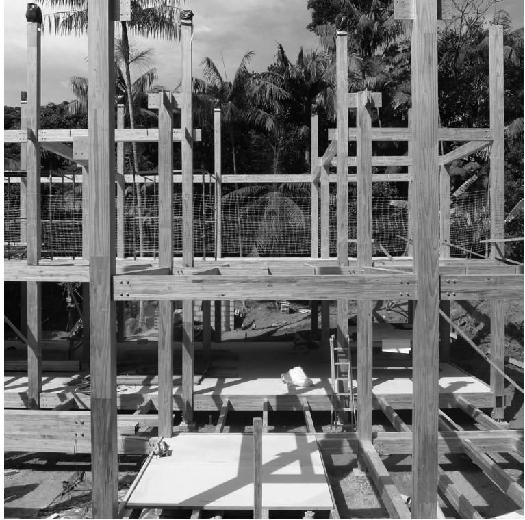
Construção estrutura, Jureia Itatins, 2019. Foto: 23 SUL
