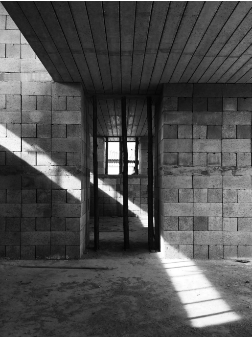
Canteiro Sede para Fabrica de Blocos. Fonte: Vão
