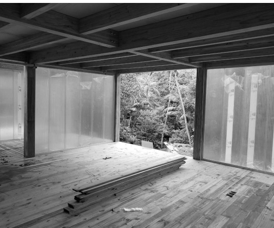
Montagem Painéis em policarbonato Jureia Itatins, 2019. Foto: 23 SUL
