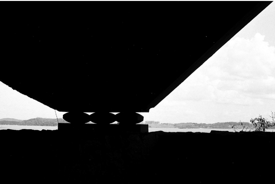
Garagem de barcos do santa paula iate clube, São Paulo, 1961. Foto: Site Vilanova Artigas
