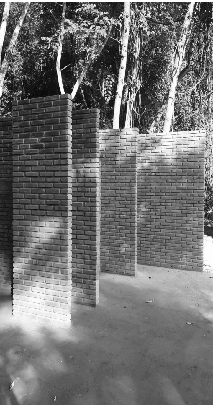
Construção paredes de alvenaria, Vale das Videiras, 2021. Foto cortesia de Gru.a
