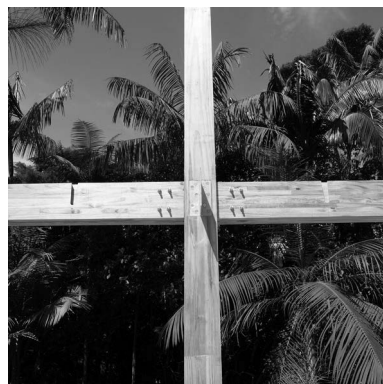
Encaixe seco entre viga e pilar em madeira, Jureia Itatins, 2019. Foto: 23 SUL
