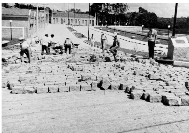
O trabalho dos calceteiros: colocação de paralelepípedos na Av. Vicente Scivittaro (região de Itupeva), 1972. Fornecido por MessinaRivas
