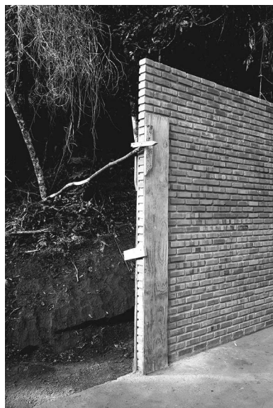
Escoramento tijolos maciços, Vale das Videiras, 2021. Foto cortesia de Gru.a
