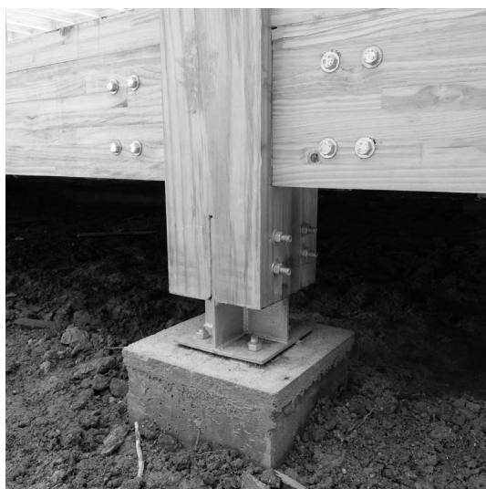
Encontro pilar-fundação, Fundação Florestal, Jureia Itatins, 2019. Foto: 23 SUL
