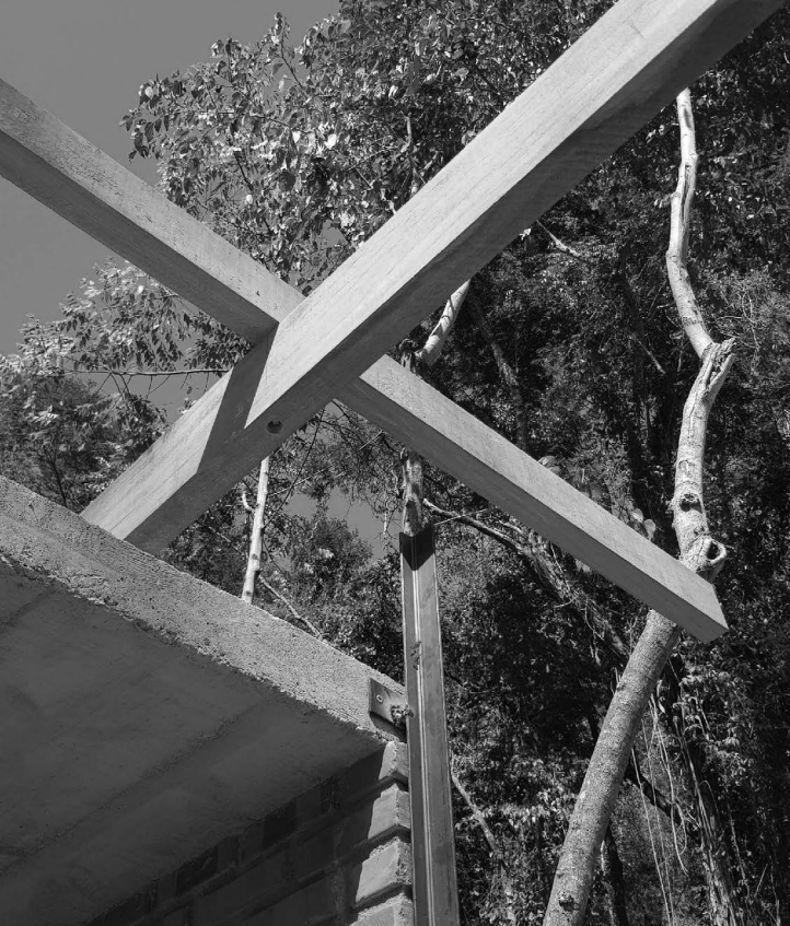
Encontro perfil metálico com a laje e alvenaria, Vale das Videiras, 2021. Foto cortesia de Gru.a
