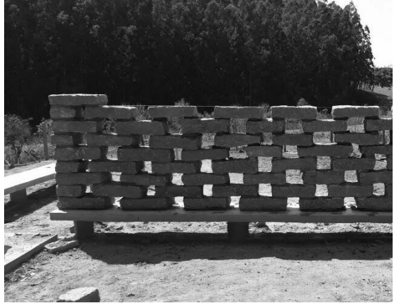
Processo de construção, Itupeva, 2017. Foto cortesia MessinaRivas
