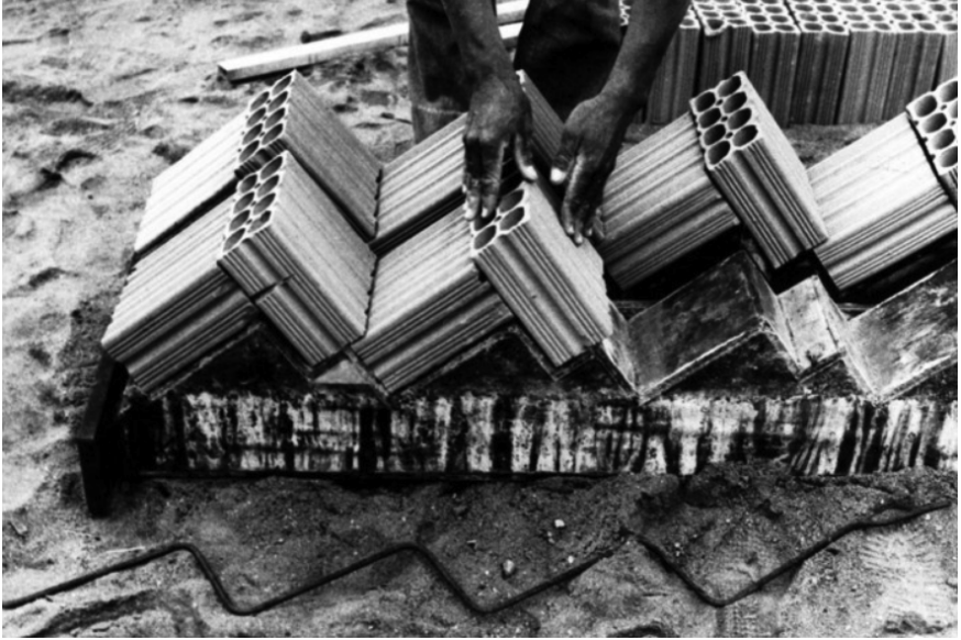
Montagem do painel escadas – blocos cerâmicos escalonados sobre forma de madeira e concretagem. Fonte: Arquivo Villà
