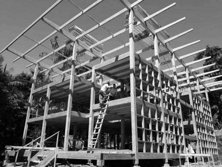
Estrutura durante a montagem, Jureia Itatins, 2019. Foto: 23 SUL
