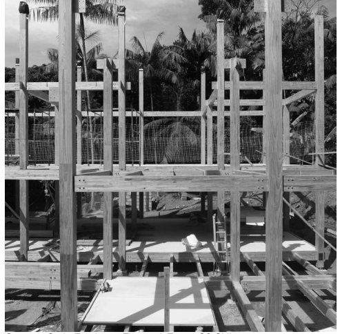
Canteiro Sede Fundação Florestal. Fonte: 23 SUL
