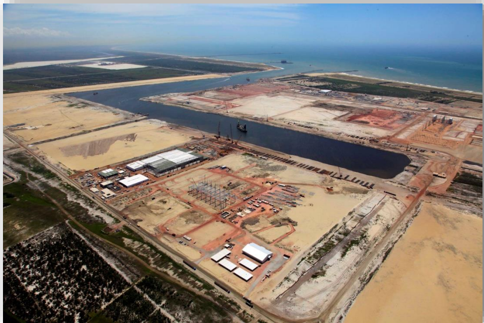
Figura 1.5 - Canal artificial no TX2 Fonte: (OSX, 2012)
