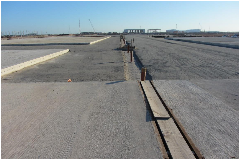
Figura 4.2 – Vista do piso em CA com detalhe de canaleta. Fonte: Visita técnica (ago/2013)
