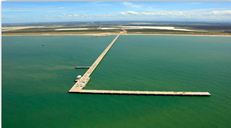
Figura 1.4 - Estrutura do píer em fase final de execução Fonte: (OSX, 2012)
