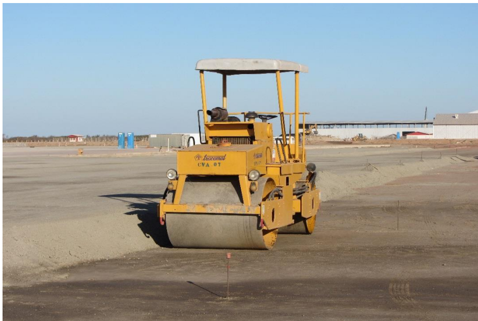
Figura 4.3 – Revestimento em BGTC. Fonte: Visita técnica (ago/2013)
