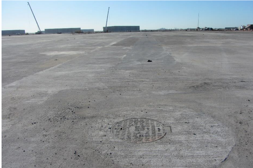
Figura 8.1 - Laje plana da área de montagem de jaquetas. Fonte: Visita técnica (ago/2013)
