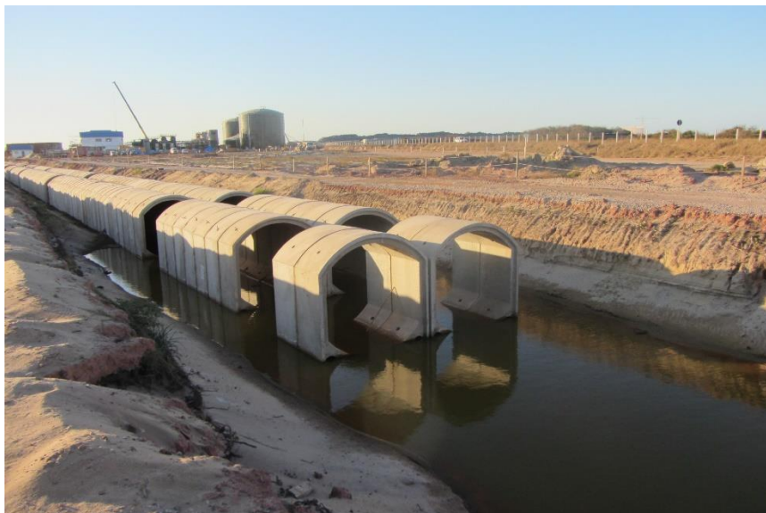
Figura 8.3 - Execução das galerias de mesodrenagem. Fonte: Visita técnica (ago/2013)
