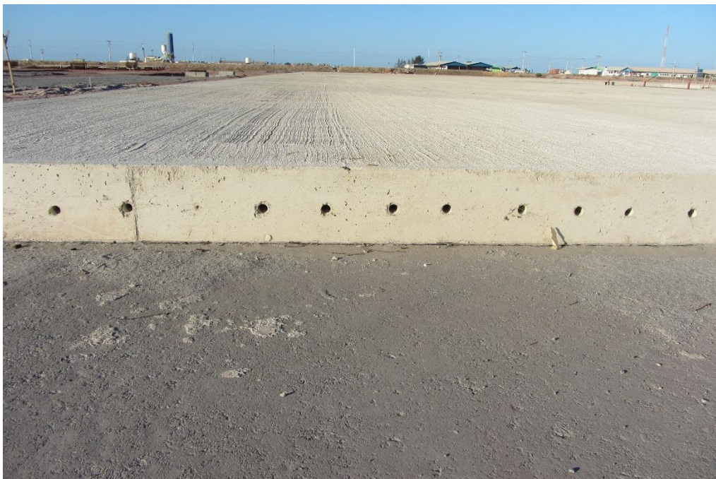
Figura 4.1 – Detalhe do piso de concreto armado. Fonte: Visita técnica (ago/2013)
