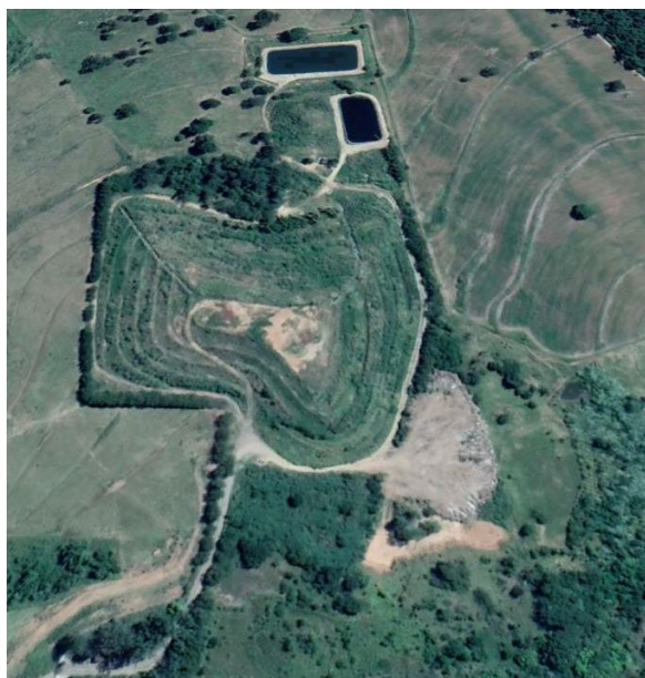
Figura 3: Aterro Sanitário Guaporé
