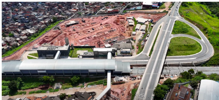
Figura 16 : Alargamento das vias próximo a nova estação Varginha
