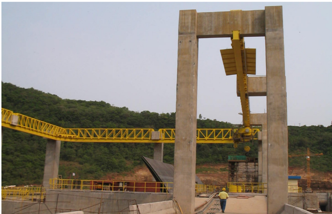
Figura 24 – Monovia curva de um vertedouro.
