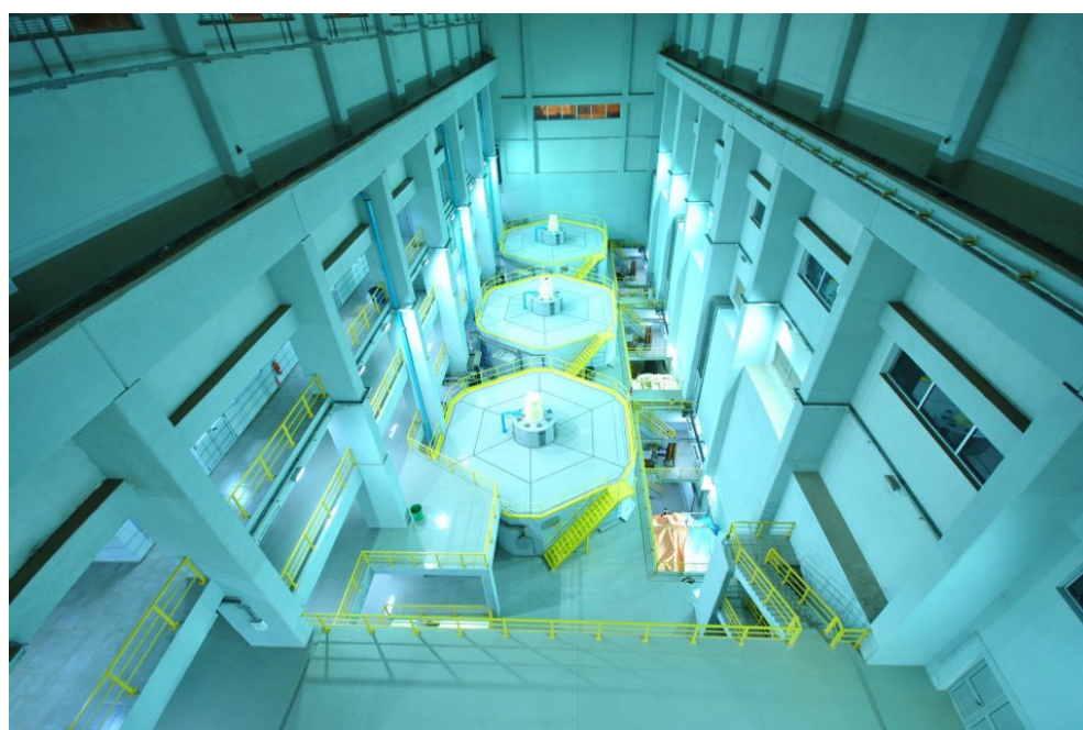
Figura 7 – Exemplo de Casa de Força externa.
