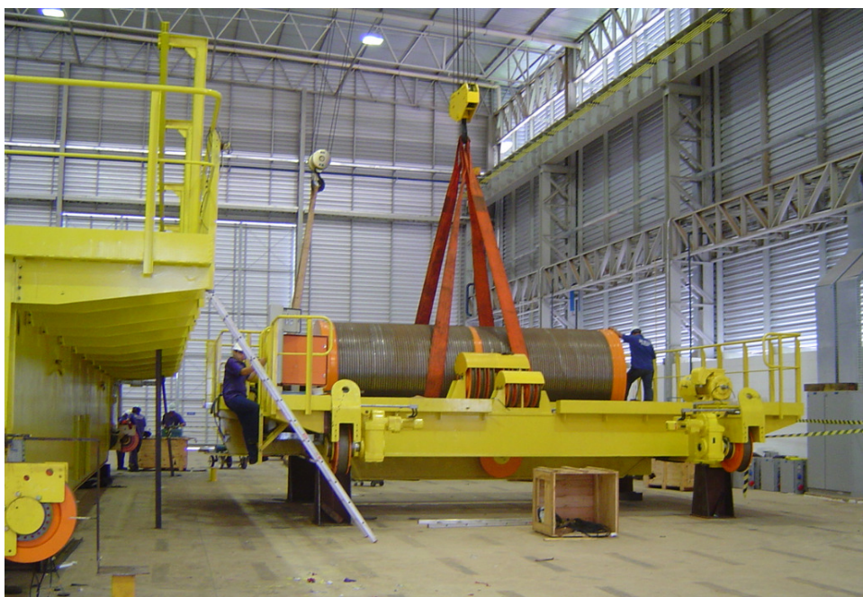
Figura 27 – Carro da ponte substituindo tambor de cabos.
