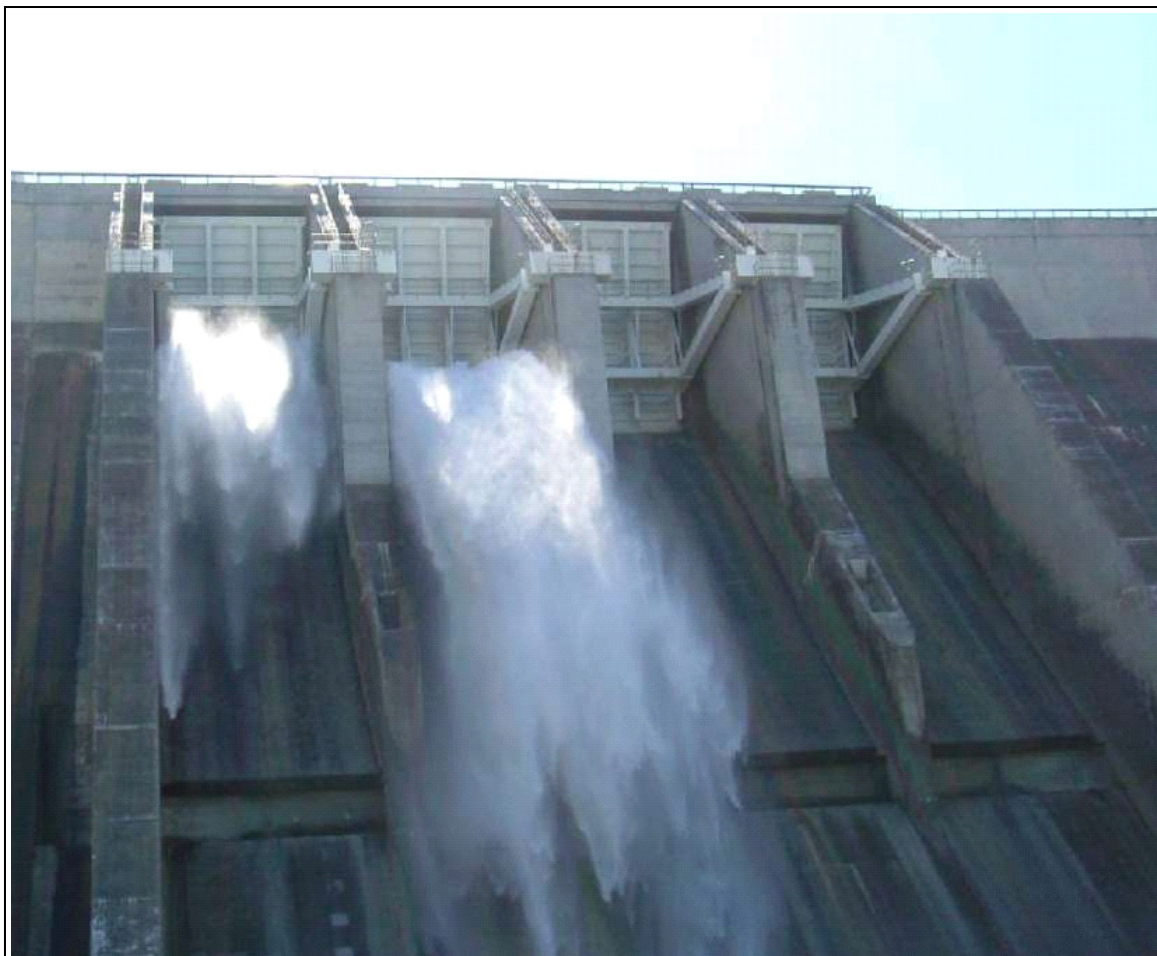
Figura 14 – Comporta segmento em processo de abertura.
