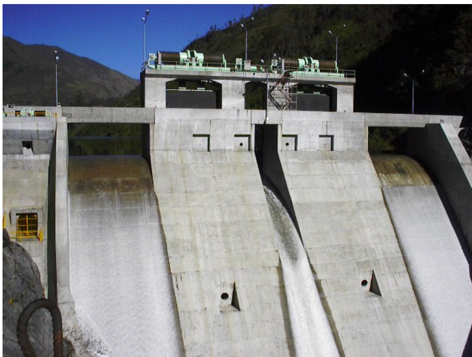
Figura 18 – Vertedouro de superfície.
