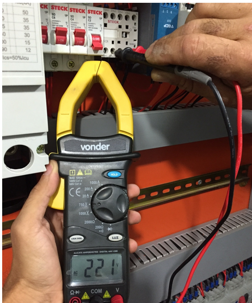
Figura 14 – Tensão Comando Partida
