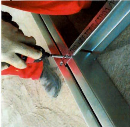
Figura 19 – Estrutura de light steel frame
