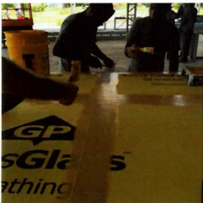
Figura 20 – Aplicação do impermeabilizante e fita na união das placas
