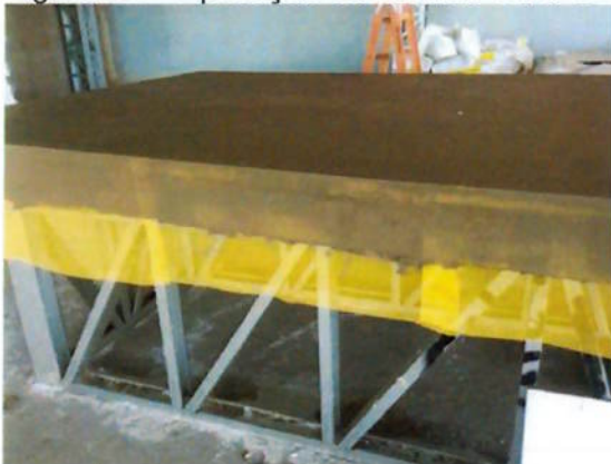
Figura 22 – Aplicação da fibra de vidro e argamassa primer
