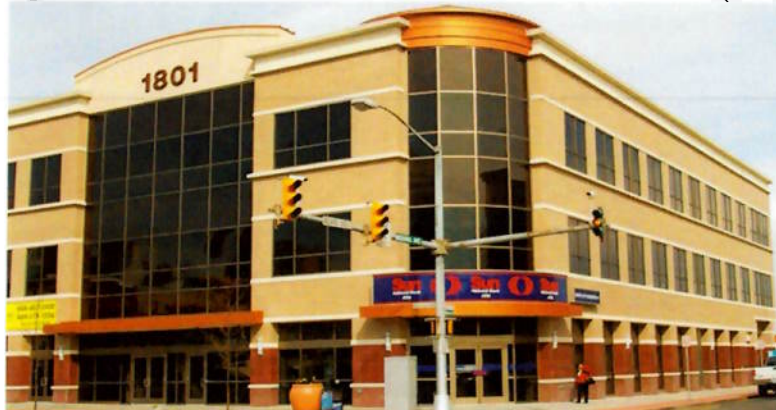
Figura 11 – Fachada com sistema EIFS: Sun National Bank (EUA)
