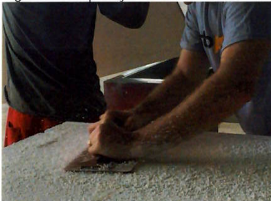
Figura 21 – Aplicação de EPS e lixamento para atingir o nivelamento desejado
