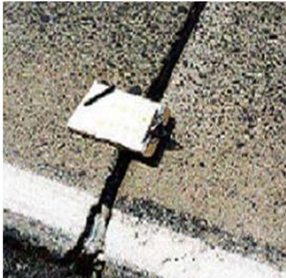
Figura 29 - Exemplo de escalonamento ou degrau nas juntas
