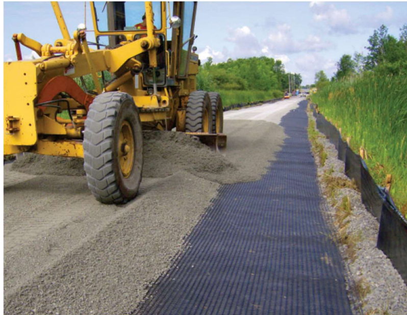
Figura 36 - Geossintéticos reforçando a base do aterro
