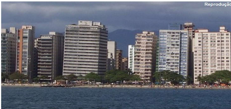
Figura 24 - Desaprumos de edifícios na cidade de Santos
