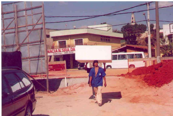
Figura 88 - Bloco de EPS carregado por operário
