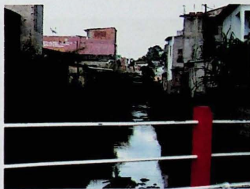
Foto 4 (PONTO 1) - Vista geral da área sujeita a inundação. Notar proximidade entre o fundo das casas e o córrego. Município: Poá (P3). Foto: Cláudio José Ferreira.
