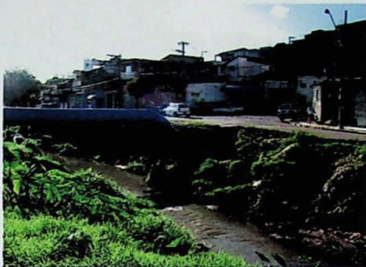
Foto 1 (PONTO 3)- Vista geral de área de inundação com presença de lixo e entulho. Presença de muros de contenção nas margens. Mauá – P3. Foto: Cláudio José Ferreira.
