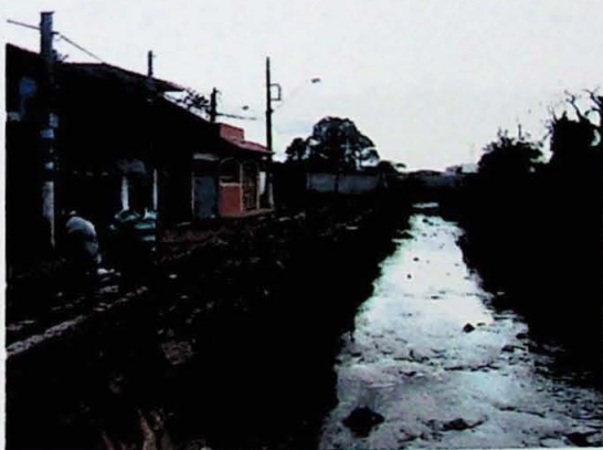
Foto 5 (PONTO 1) - Parte do córrego próximo do trecho anterior, com trabalhadores construindo muro de contenção. Presença de lixo, erosão recente nas margens e assoreamento. Município: Poá (P3). Foto: Cláudio José Ferreira.
