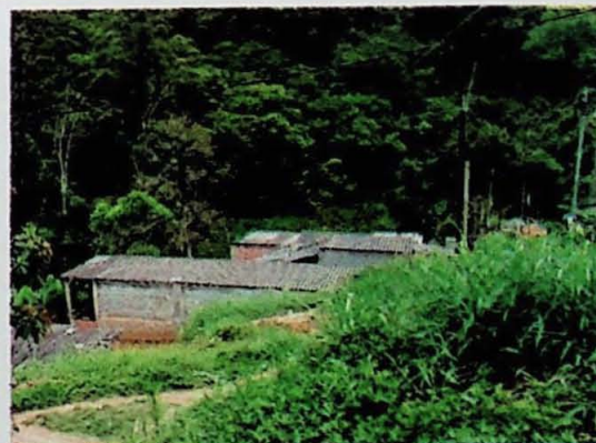
Foto 6 (PONTO 2) - Área de inundação (descrição de moradores) no fundo do vale próximo a ocorrência de escorregamento. Município: Ferraz de Vasconcelos (P3). Foto: Cláudio José Ferreira.
