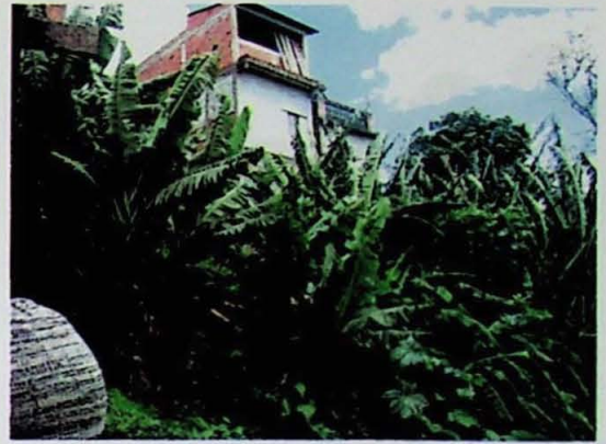
Foto 8 (PONTO 5) - Vista para a área que, segundo um morador, sofreu processo de deslizamento de terra em janeiro/2011. Município: Ferraz de Vasconcelos (P4). Foto: Cláudio José Ferreira.
