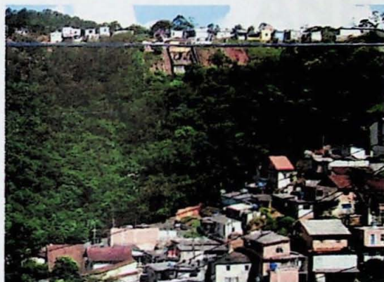
Foto 23 (PONTO 12) – Vista geral da área. Inclinação acentuada da encosta e dos taludes de corte. Município: Ribeirão Pires. Foto: Cláudio José Ferreira.
