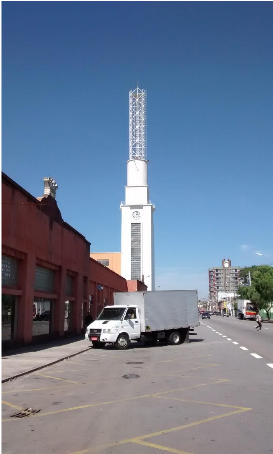
Imagem 21 - Torre da CICA recém restaurada
