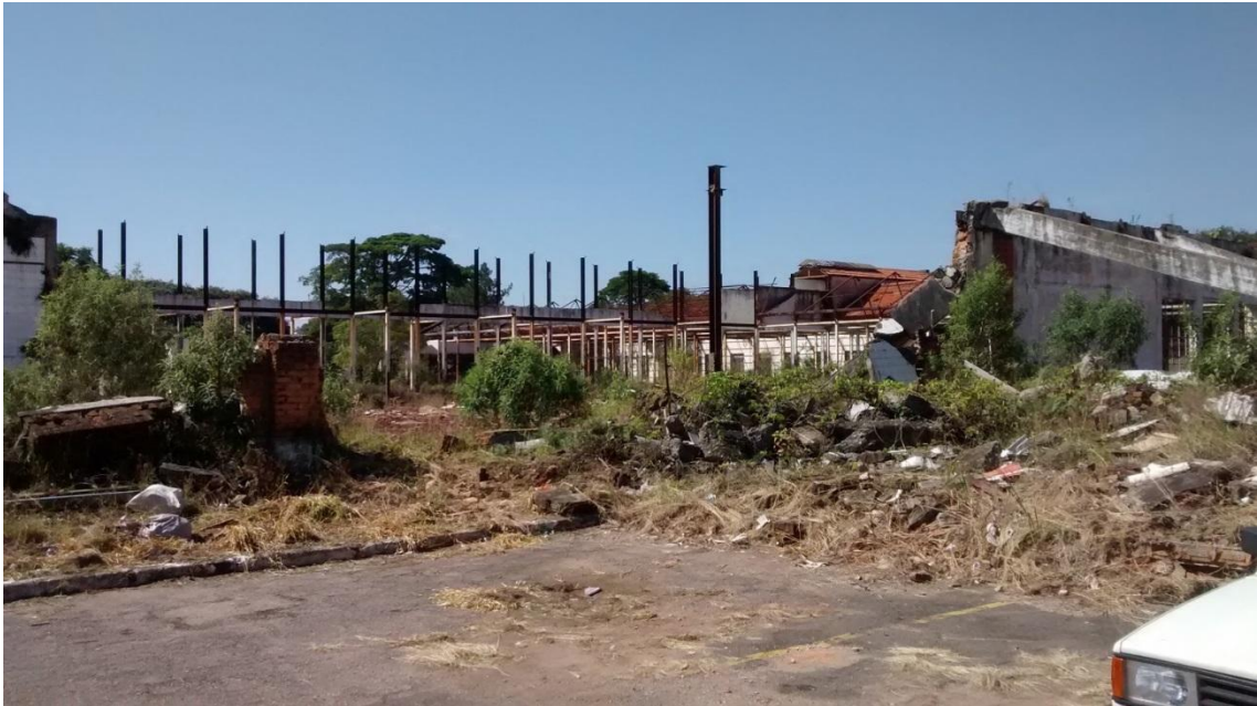
Imagem 24 - Vista da parte posterior da Tecelagem Japy parcialmente demolida
