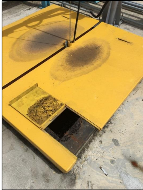
Figura 9 - Janela de inspeção
