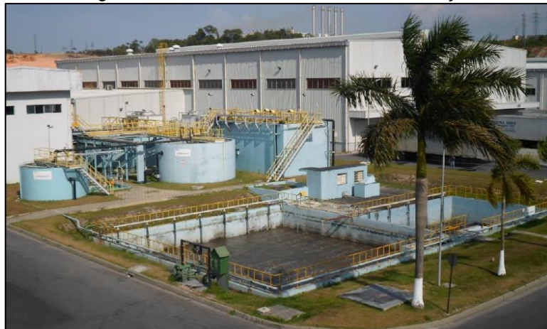
Figura 2 - ETE antes da obra de modernização
