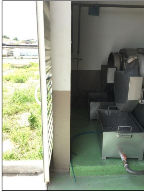
Figura 21 - Instalações físicas da peneira.
