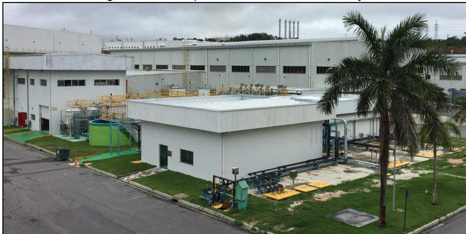
Figura 3 - ETE após as obras de modernização
