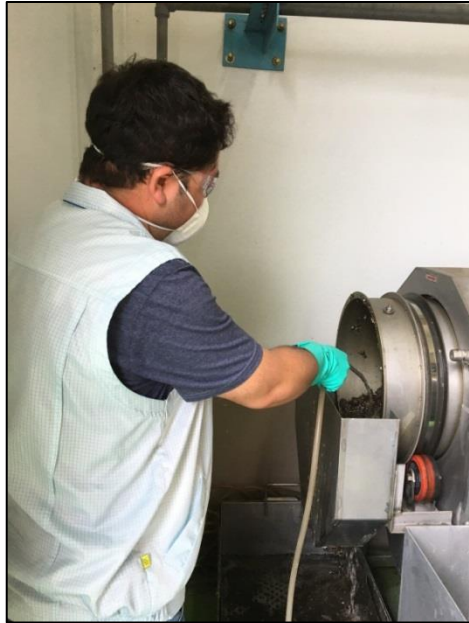
Figura 15 - Retirada dos dejetos da peneira rotativa.
