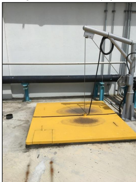
Figura 8 - Caixas de inspeção
