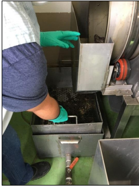
Figura 14 - Verificação do funcionamento do dreno de água
