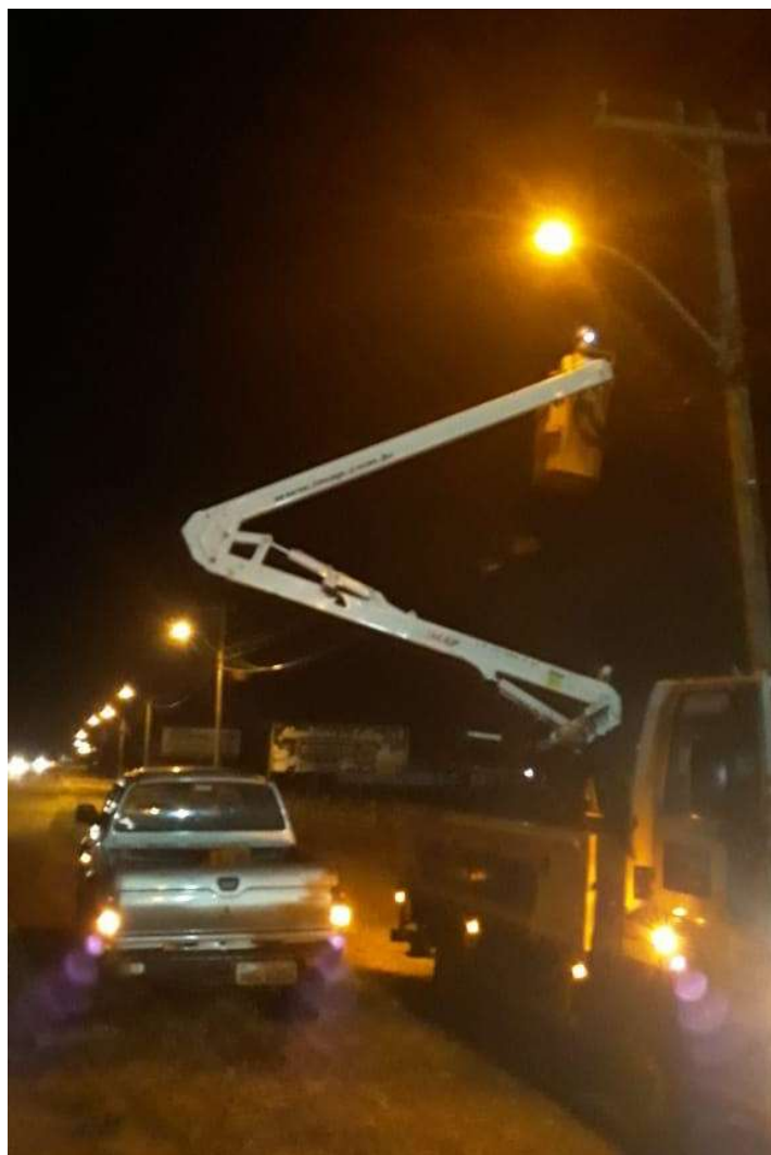
Figura 12 – Substituição de lâmpada VSAP 250W
