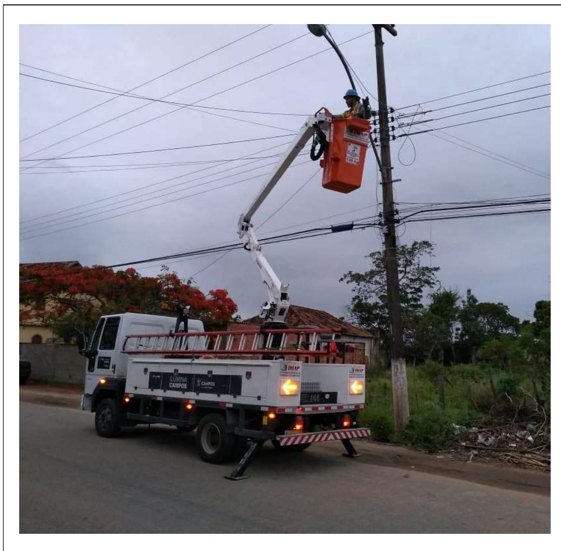
Figura 28 – Substituição de cabos de cobre do circuito da luminária.
