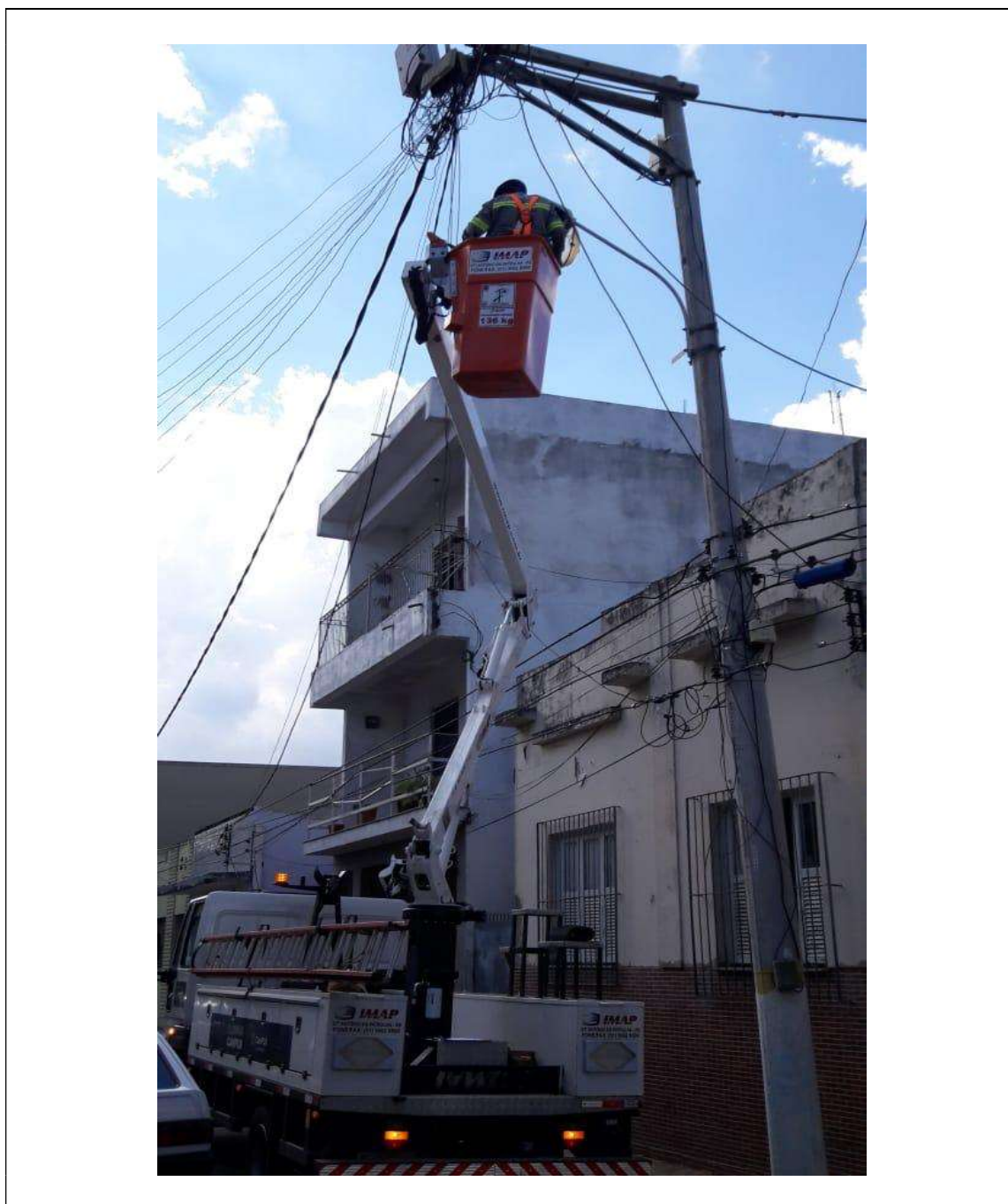
Figura 34 – Substituição de lâmpada VSAP 70W em rua estreita.
