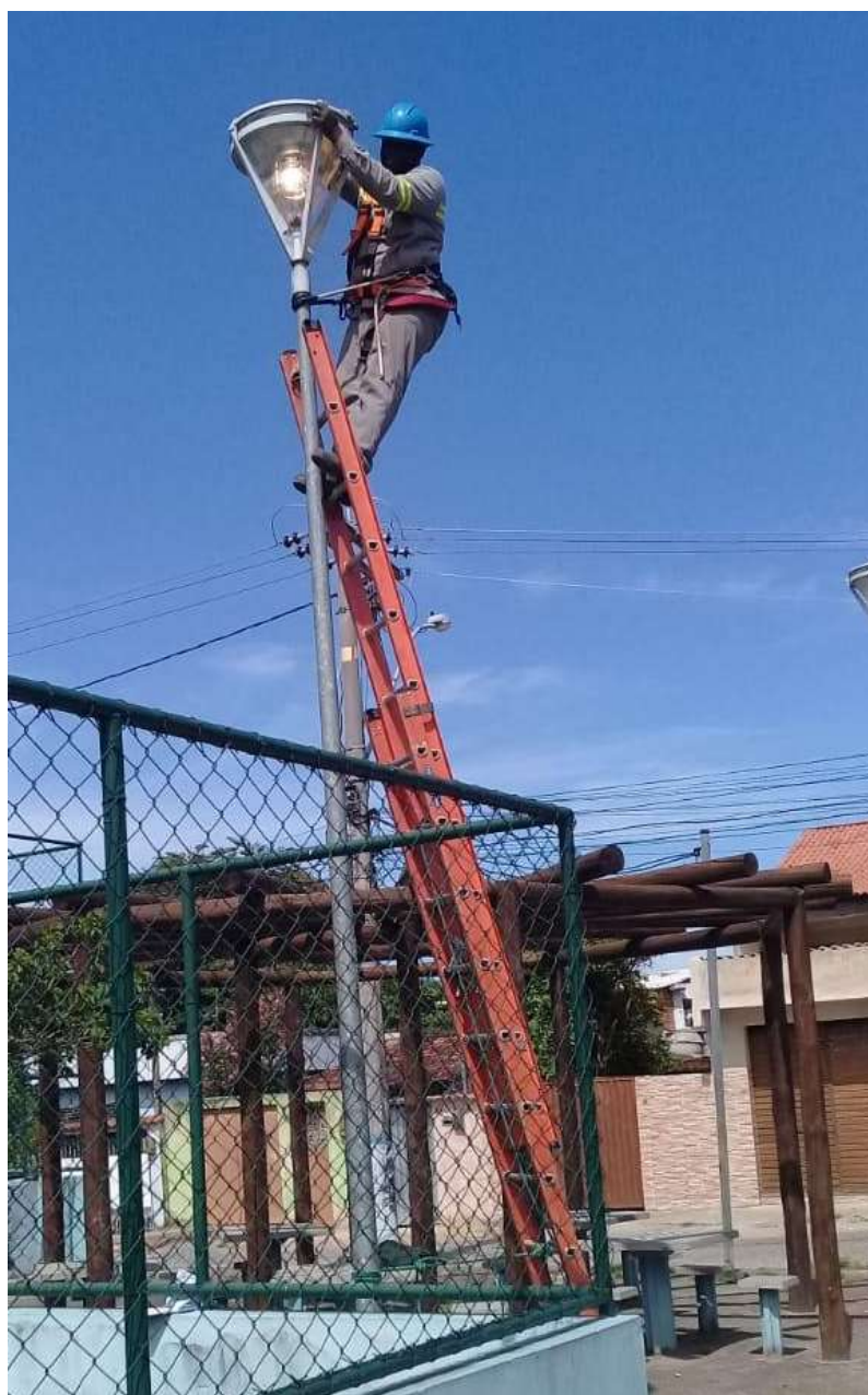
Figura 13 – Manutenção em luminária ornamental MVM 150W
