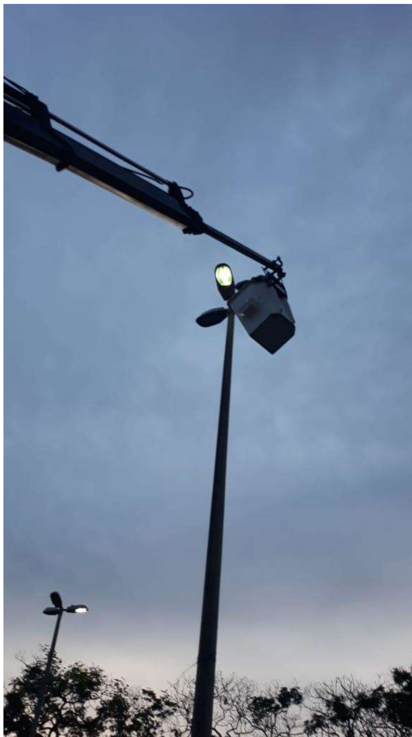
Figura 22 – Substituição de reatores internos em luminária instalada em suporte.
