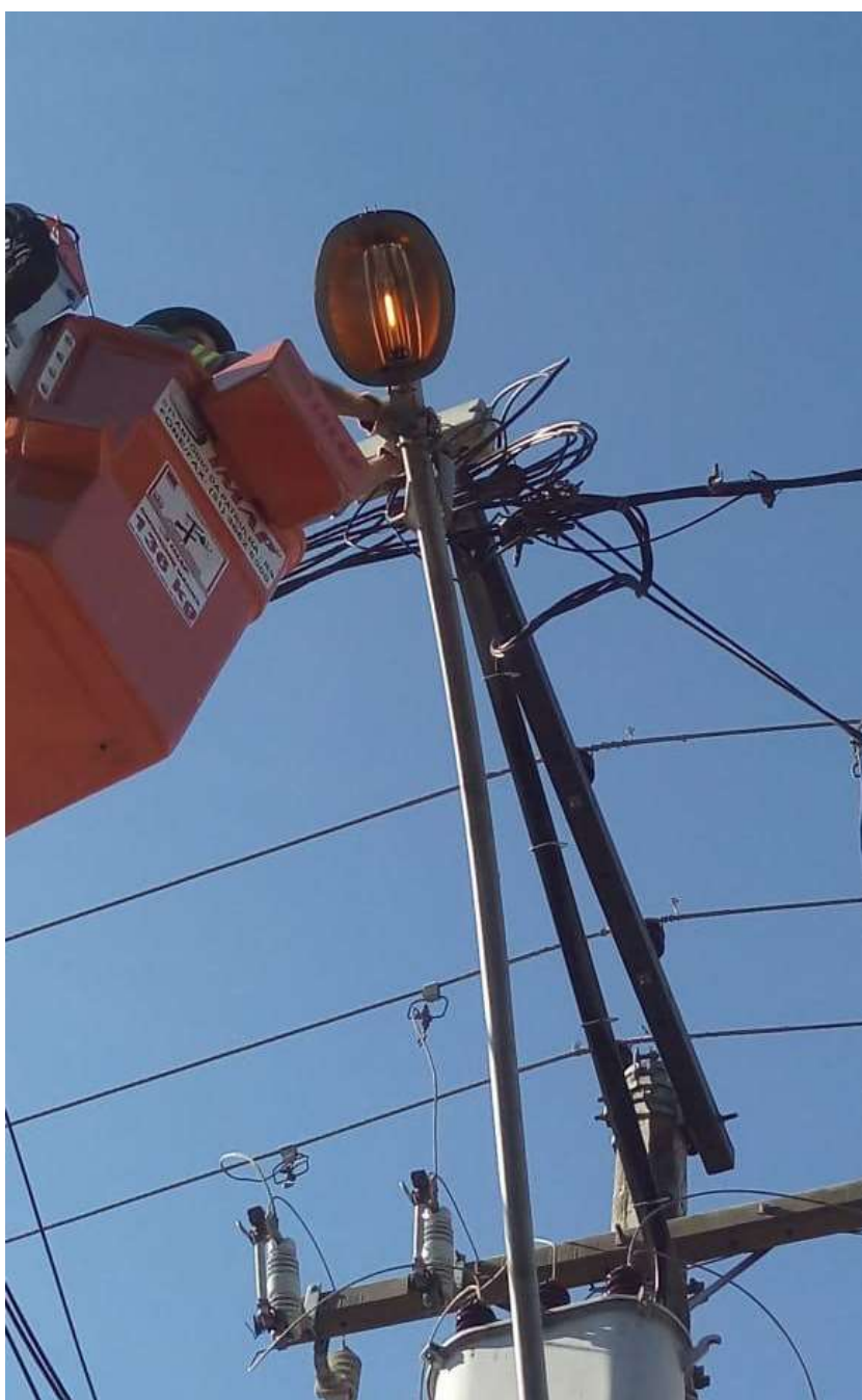
Figura 19 – Substituição de reator próximo a rede de média tensão
