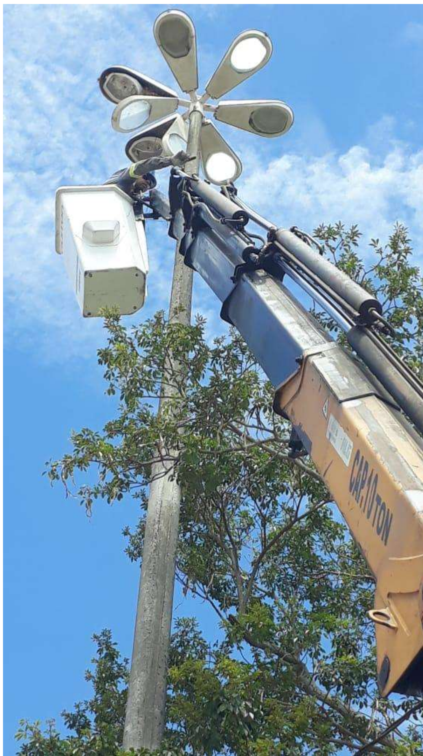
Figura 20 – Substituição de lâmpadas em suporte de aço.
