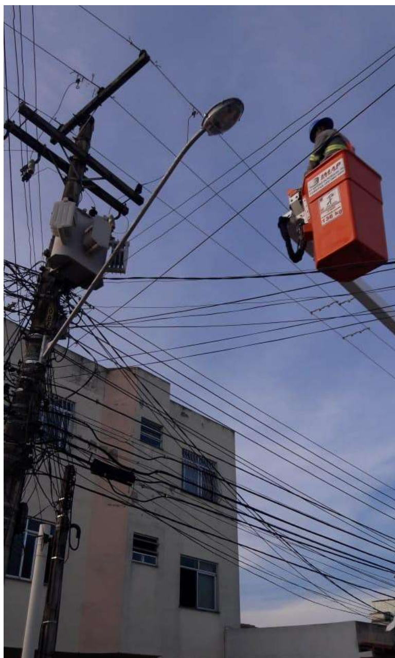
Figura 23 – Substituição de lâmpada em luminária próxima à rede de média tensão.
