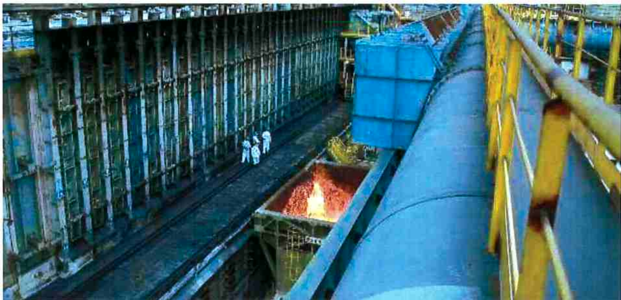
Figura 6 - Coqueria 3 da Usiminas Ipatinga, que entrou em operação em 2010 [28]
